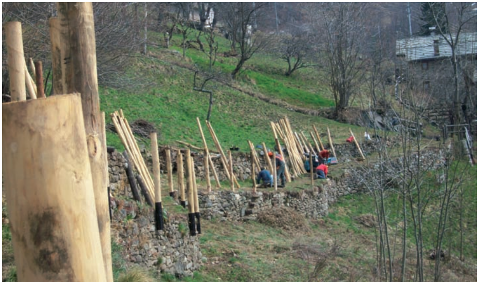
Cappella di Pillaz durante i lavori
