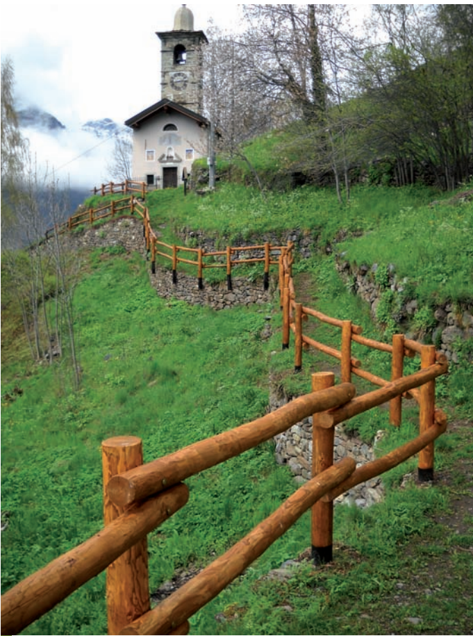
Cappella di Pillaz dopo l'intervento
