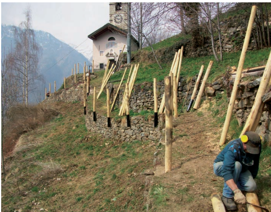
Cappella di Pillaz durante l'intervento
