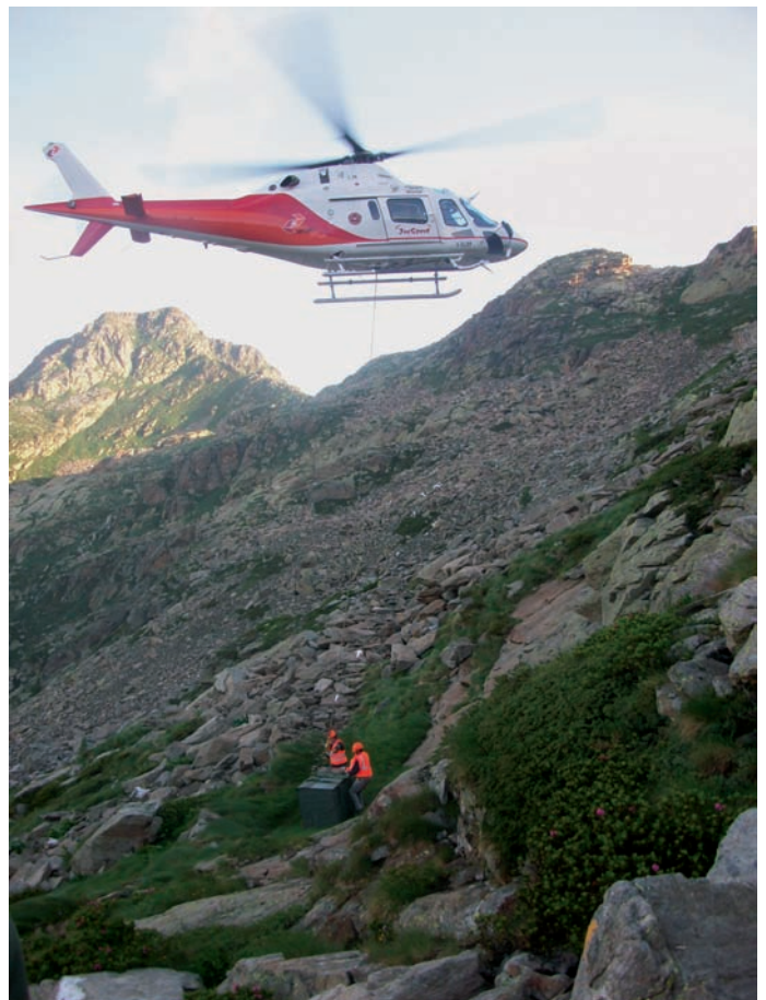
Allestimento del cantiere al Colle della Balma
