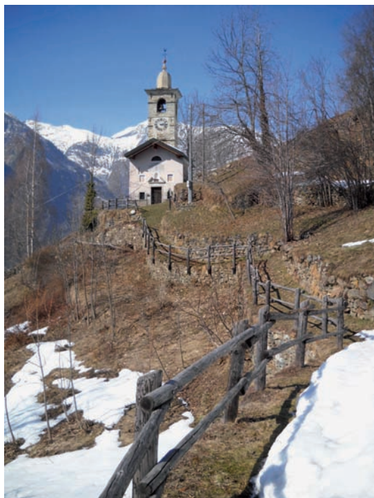
Cappella di Pillaz prima dell'intervento
