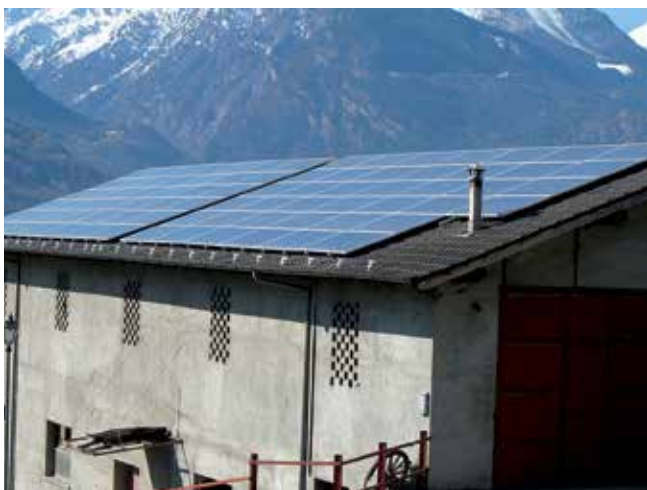
Impianto fotovoltaico su falda
