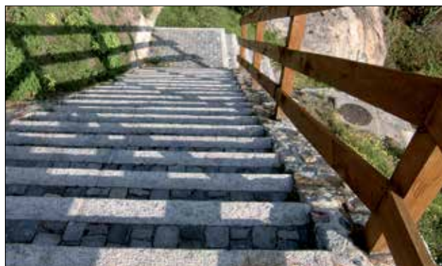
Bard, lavori di risanamento della viabilità di accesso alla frazione di Altobard
