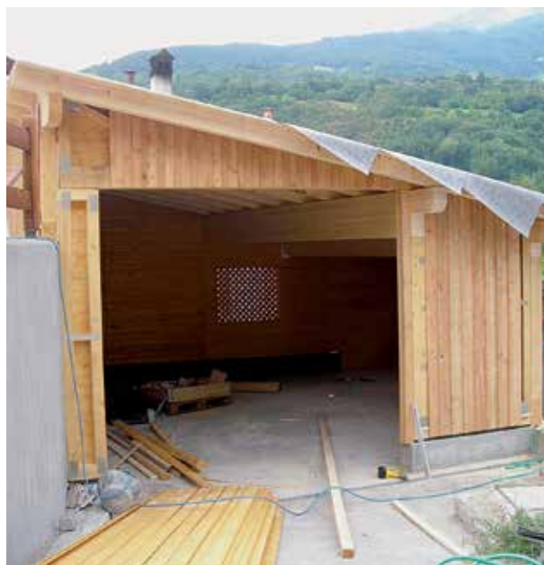
Impianto di riscaldamento a cippato, struttura per l'essiccamento del cippato
