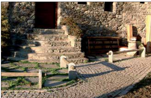
Valpelline, lavori vari nel villaggio Toules Dessus
