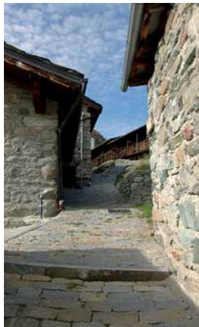
Torgnon, lavori di ripristino della viabilità interna e dei sottoservizi del villaggio Triatel
