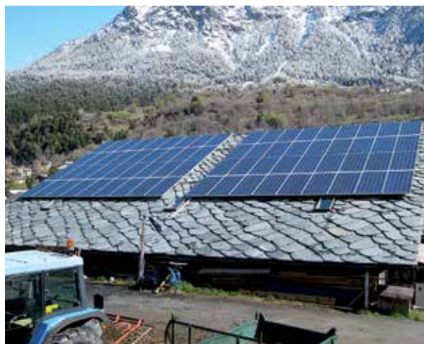
Impianto fotovoltaico su falda
