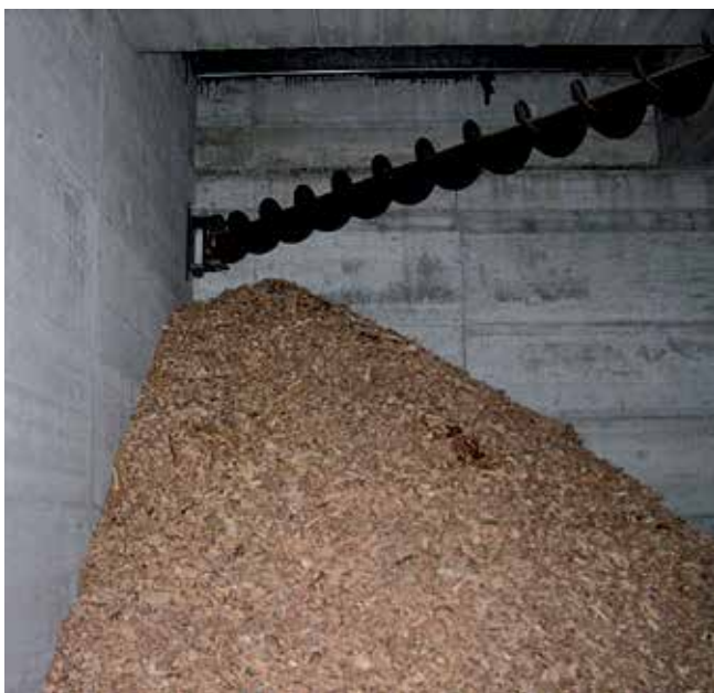
Impianto di riscaldamento a cippato, serbatoio del cippato con sistema di alimentazione a coclea
