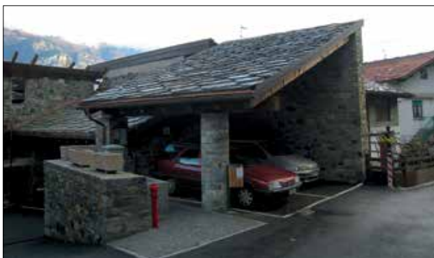
Pontey, realizzazione di opere varie nei villaggi di Prelaz e Tzesanouva
