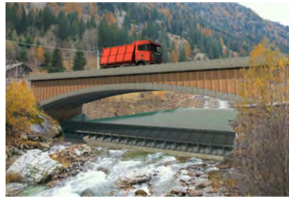
(b) Ponte ad arco in cemento armato
