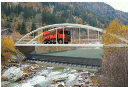
(c) Ponte ad arco in acciaio
