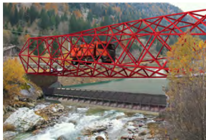
(g) Ponte in acciaio reticolare twist
