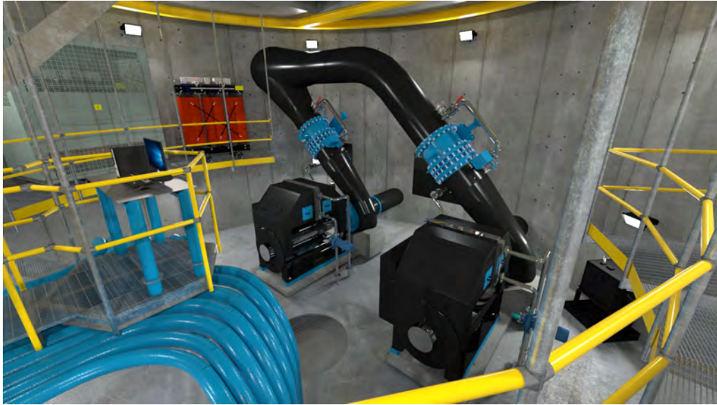
Figura 12.20: Vista assometrica dell'interno del locale centrale, sulla sinistra il pulpito con il PC di controllo dell'impianto, sullo sfondo i due gruppi di produzione Francis.
