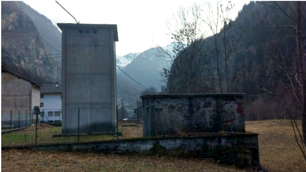
Figura 12.26: Vista da monte del torrino Deval esistente e sulla destra il locale dismesso che verrà demolito per lasciare posto alla nuova cabina.
