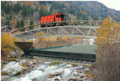
(e) Ponte in acciaio reticolare ad arco
