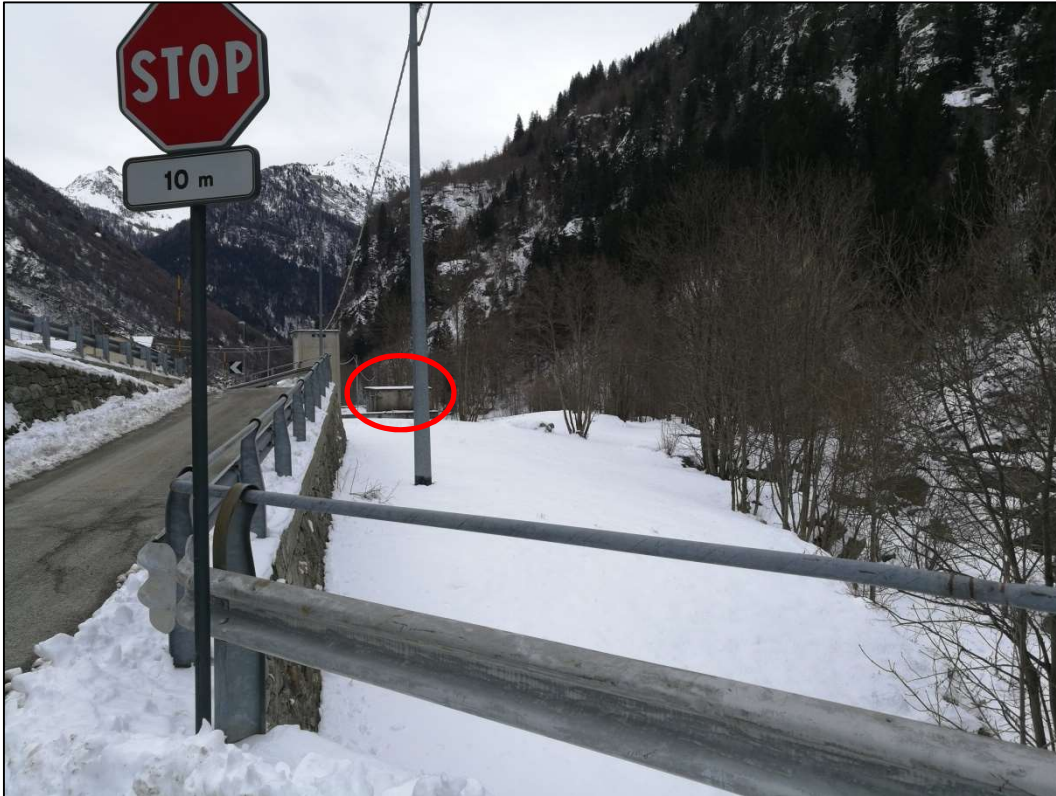
Figura 18: in evidenza si ha la cabina di distribuzione Deval che verrà allacciata con la centrale idroelettrica tramite un cavo aereo.
