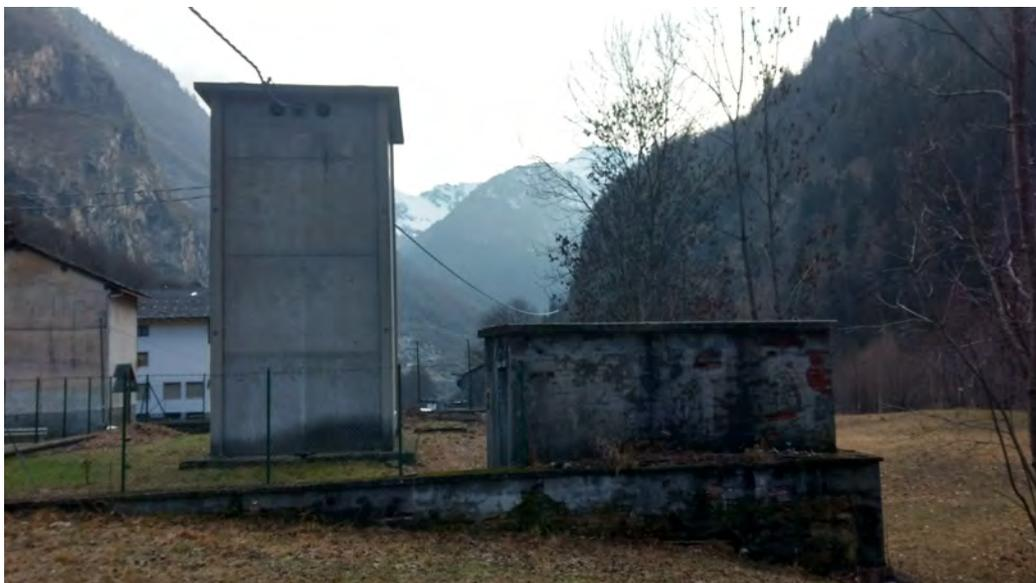
**Figura 3.21:** *Vista da monte del torrino Deval esistente e sulla destra il locale dismesso che verrà demolito per lasciare posto alla nuova cabina.*
