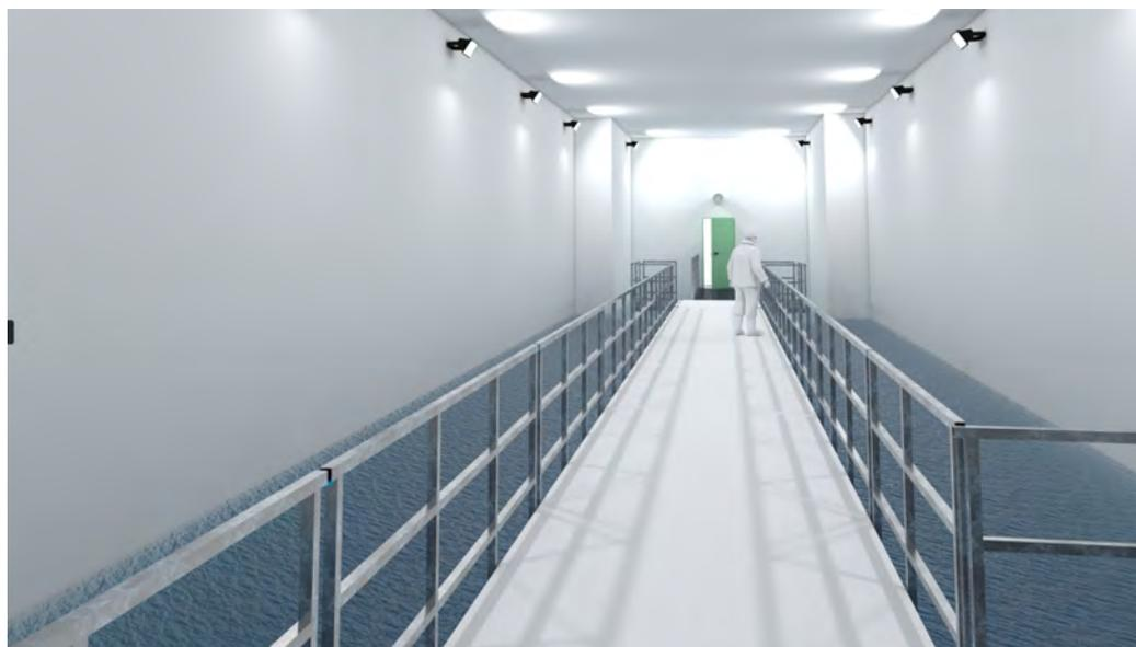
**Figura 3.8:** *Vista interna della vasca di carico. In primo piano la passerella pedonale che divide la vasca di carico. Sullo sfondo la porta di accesso alla camera valvole.*
