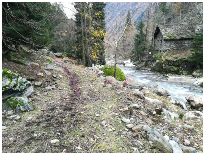
Figura 3.4: Vista da monte della pista poderale esistente in sinistra idrografica sotto la quale verrà posizionata la condotta forzata.
