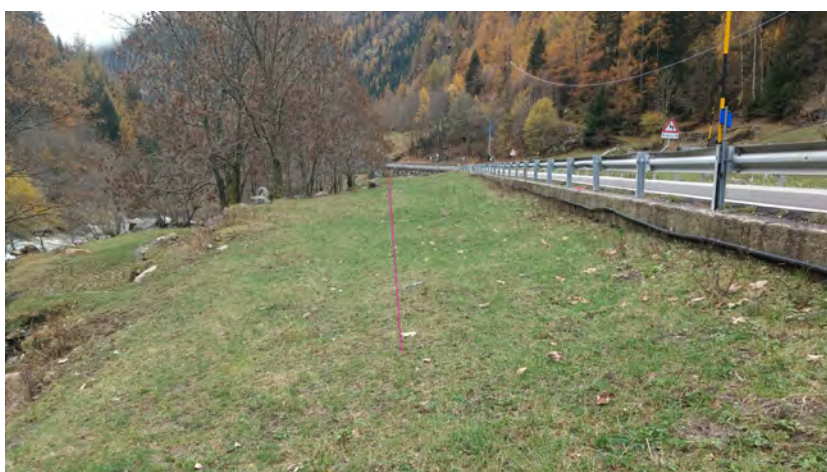
Figura 3.8: Vista da monte del tratto di prato a valle della strada regionale lungo il quale verrà posata la condotta forzata interrata.
