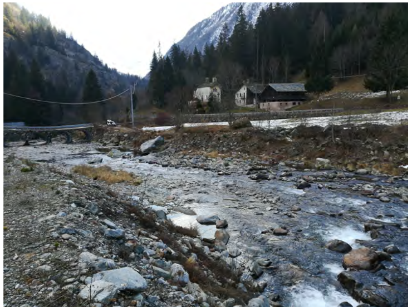
Figura 3.3: Vista generale da monte del guado attuale. Il guado verrà rimosso e sostituito con l'opera di presa in progetto sormontata dal nuovo attraversamento.
