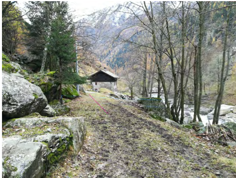
Figura 3.5: Vista da monte della pista poderale esistente in sinistra idrografica sotto la quale verrà posizionata la condotta forzata.
