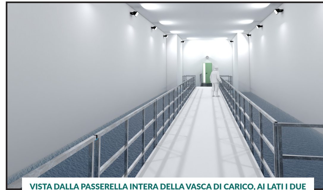
VISTA DALLA PASSERELLA INTERA DELLA VASCA DI CARICO, AI LATI I DUE CANALI DISSABBIATORI. SULLO SFONDO L'ACCESSO ALLA CAMERA VALVOLE
