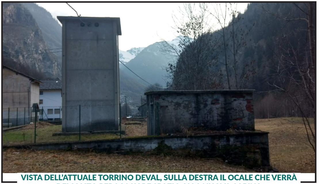
VISTA DELL'ATTUALE TORRINO DEVAL, SULLA DESTRA IL COCALE CHE VERRÀ DEMOLITO PER LASCIARE SPAZIO ALLA NUOVA CABINA
