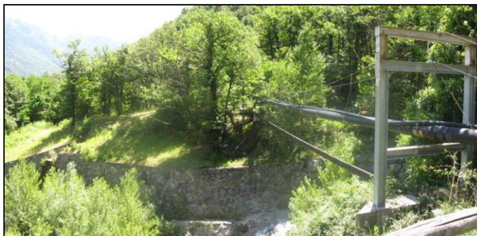
**Foto 23-24.** Vista della vasca esistente di Sommet de Ville e del punto in cui la tubazione esistente attraversa per via aerea il T. Beaucqueil.
