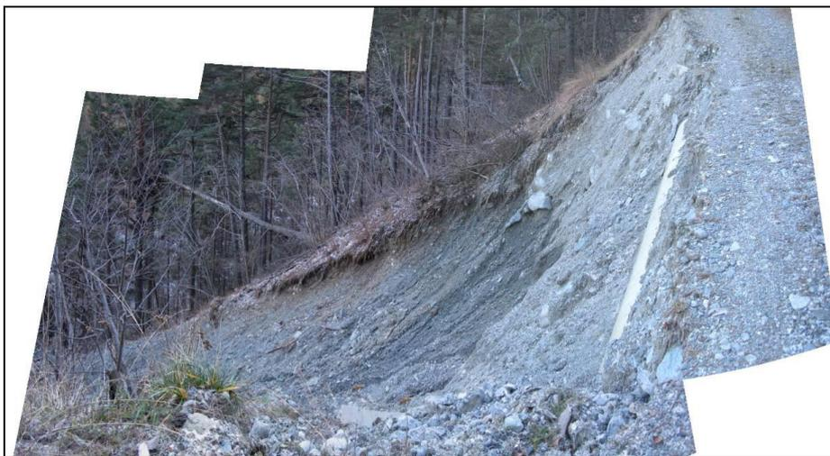
**Foto 55.** Vista di dettaglio da E-NE della nicchia di distacco. In primo piano è visibile il margine esterno della tubazione della condotta forzata.
