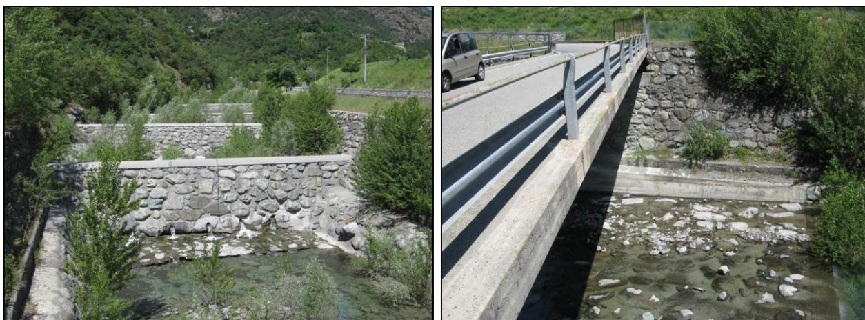
**Foto 37-38.** Vista dell'alveo del T. Chalamy con numerose soglie in pietra e malta e dettaglio del ponte.
