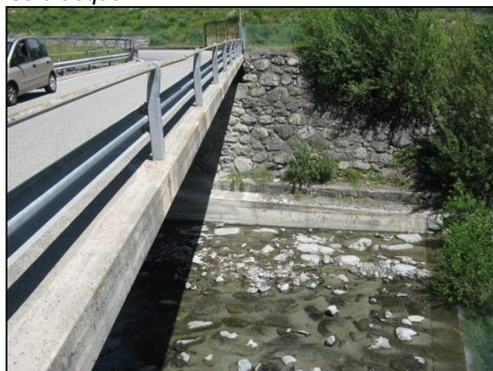
**Foto 17.** Lato di valle del ponte esistente ove verrà staffata la tubazione
