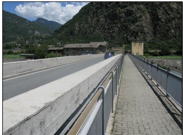
**Foto 25-26.** Vista da W del ponte della S.R.4 sulla Dora Baltea lungo cui si snoderà la tubazione venendo staffata lungo il lato di valle dell'impalcato.
