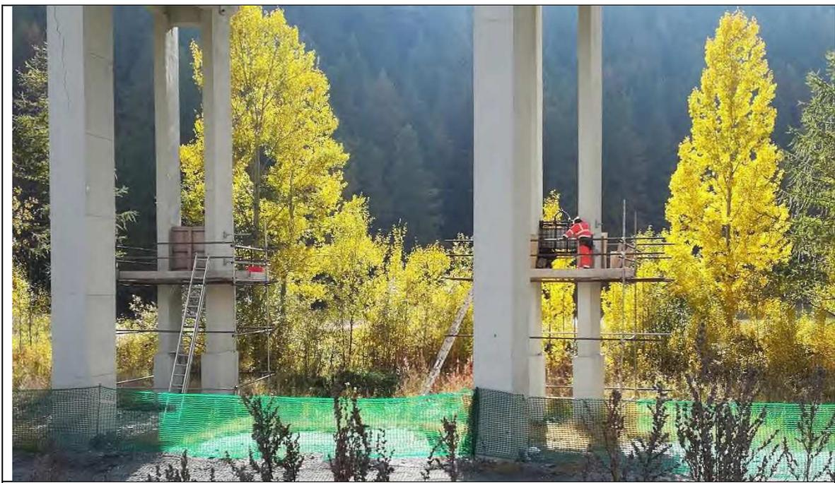
*Rinforzo strutturale travi di rilegamento "TB" del tratto in curva del viadotto Curvone*
