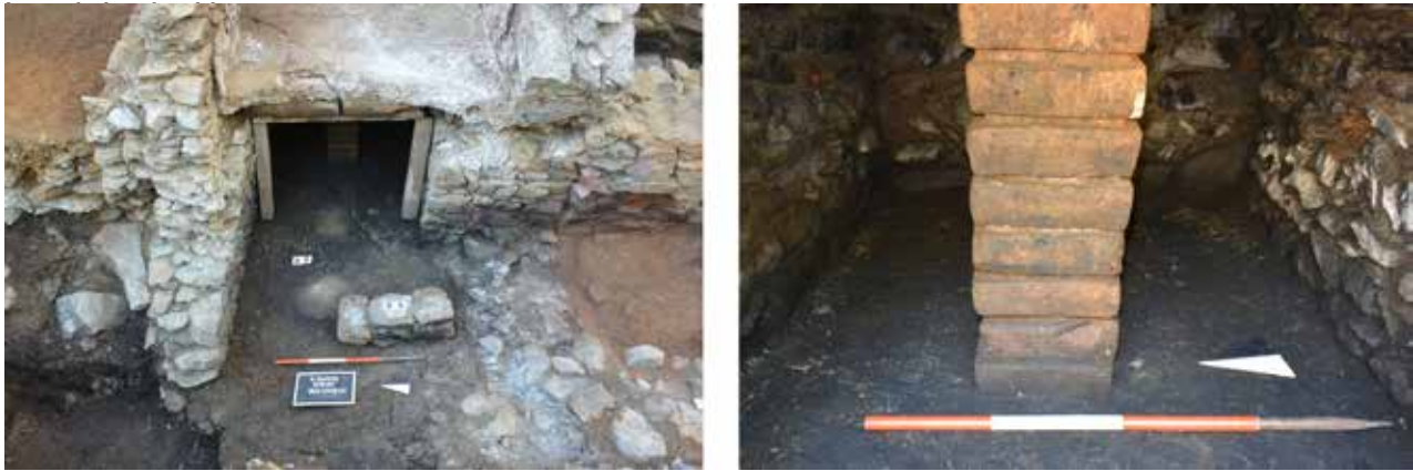
Fig. 23. Saint-Marcel, località Étéley, imbocco e dettaglio del sistema di suspensurae con pilae in bessali (Armirotti et alii 2021b).
