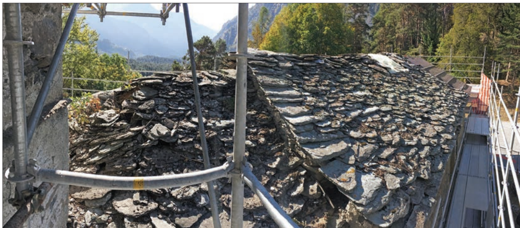
7. Stato di conservazione della copertura a inizio lavori. (S. Martino)
