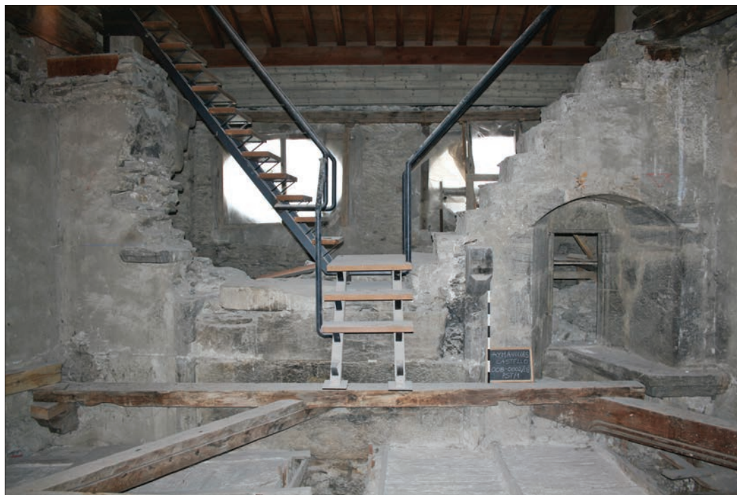
10. Sottotetto, parete est, traccia di un grande camino con mensola in bardiglio. (M. Cortelazzo)
