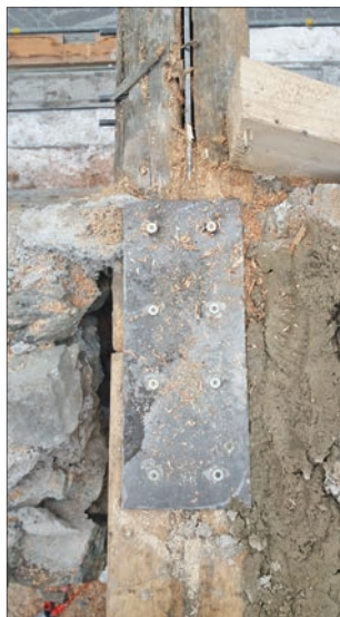
13a-b. Consolidamento e conservazione della travatura dell'avantetto. (S. Martino)
