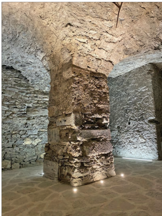
13. Uno dei pilastri di sostegno delle volte delle cantine settentrionali e del loggiato soprastante. (A. Novel)
