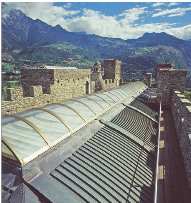
2. Particolare della copertura attuale. (F. Coluzzi)
