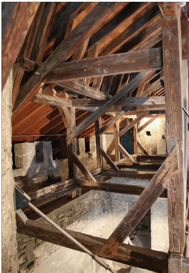
28. Vista della campata sud del tetto. (M. Cortelazzo)
