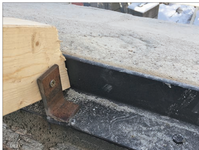
11. Particolare del colmo e del nuovo sistema di scarico metallico. (S. Martino)
