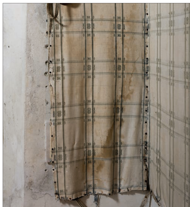
3-4. La stanza da bagno della regina e, in basso, particolare del degrado di intonaco e tappezzeria nella parte inferiore della parete perimetrale. (G. Gallarate)
