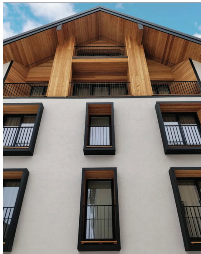
14. Facciata dell'ampliamento, particolare. (E. Mazzocchi)
