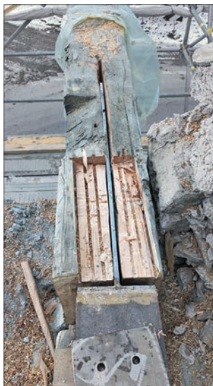
13a-b. Consolidamento e conservazione della travatura dell'avantetto. (S. Martino)
