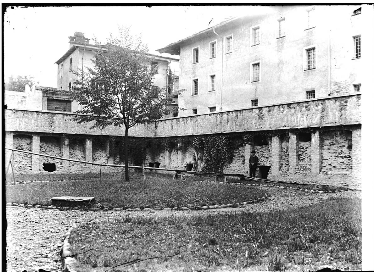
6. Il parterre del Criptoportico a lavori quasi conclusi (la canaletta di scolo che lo attraversa è provvisoria). Si notino i caratteristici pilastri di sostegno realizzati nei lati est e nord. (Archivi beni archeologici)
