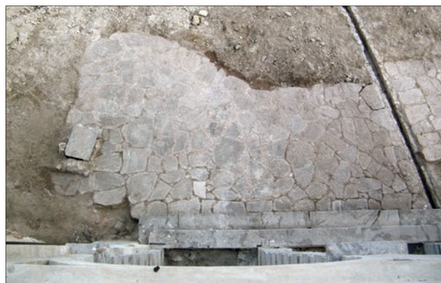
23. Il lastricato messo in opera per l'impermeabilizzazione dei vani cantinati settentrionali. (S. Navigato)
