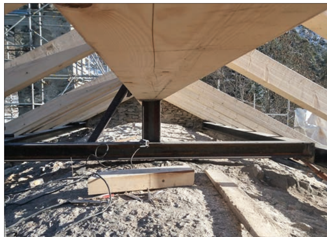
11. Particolare del colmo e del nuovo sistema di scarico metallico. (S. Martino)
