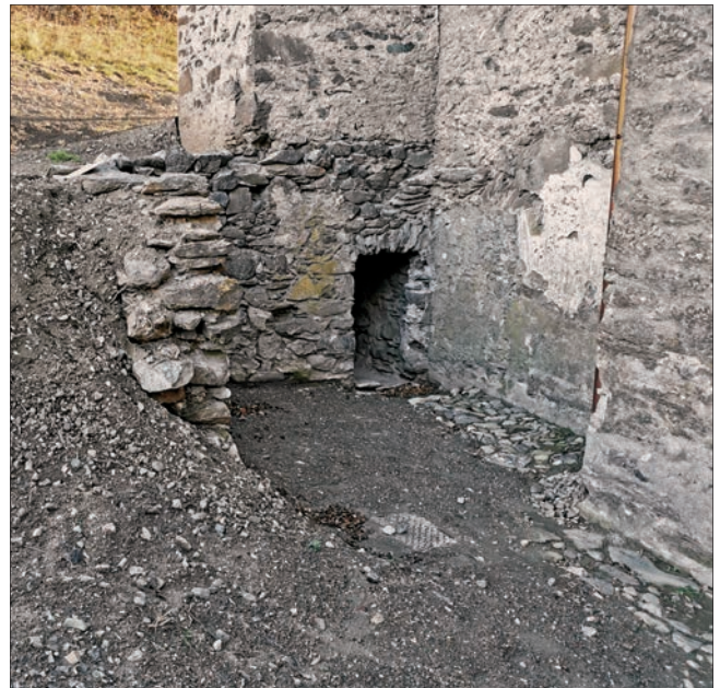
21. Il cosiddetto vano sacrestia visto da nord-ovest a fine lavori. (C. Joris)
