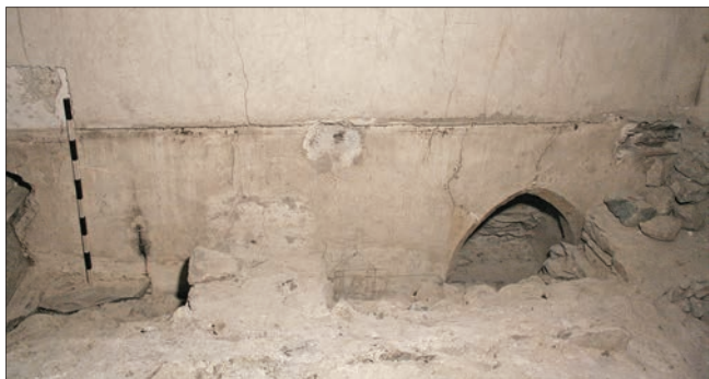
6. Particolare del voltino ad arco acuto di una delle porte di comunicazione tra la torre e il prisma centrale. (M. Cortelazzo)
