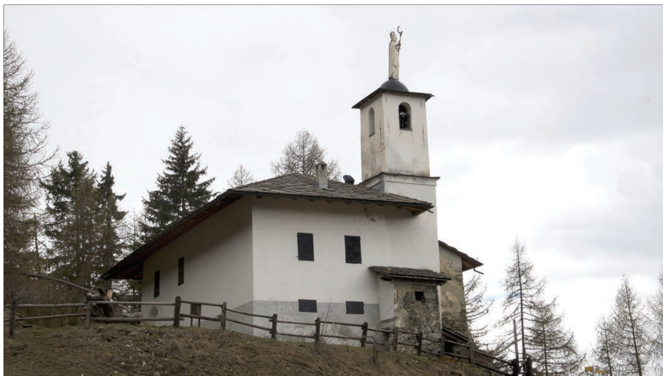
1. Veduta dell'Eremo di San Grato, prima del restauro della scultura lignea posta sul campanile. (Pm. Reboulaz)
