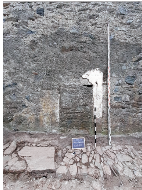
23. La parete nord con la porta tamponata di accesso alla navata. (C. Joris)
