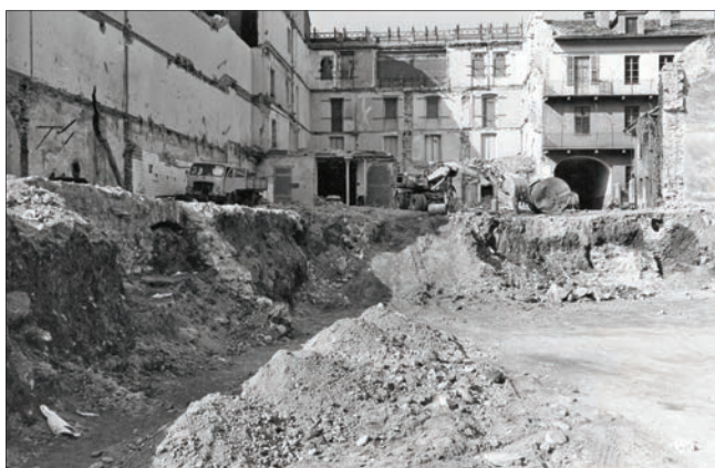
7. Retro dell'Hôtel Couronne durante la demolizione del 1980. (Archivi beni archeologici)
