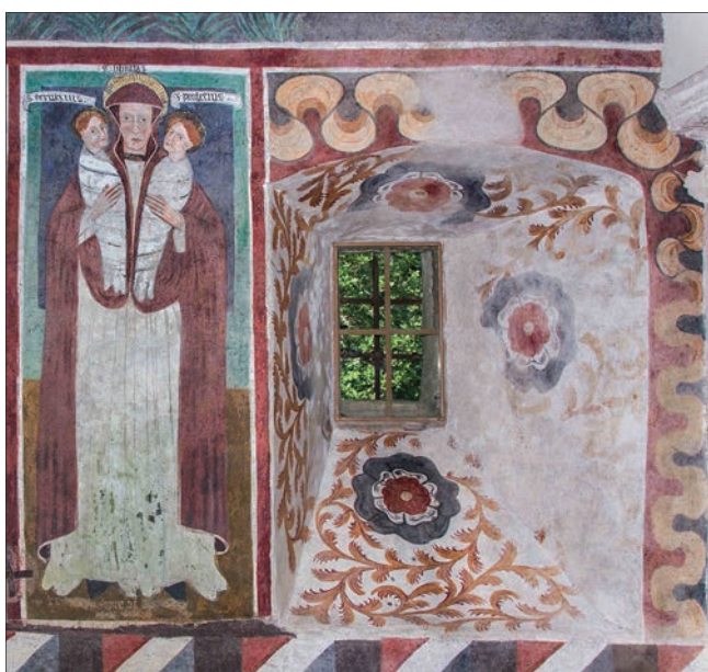
30. Santa Liberata e la finestra, dopo il restauro. (Ph. Trossello)
