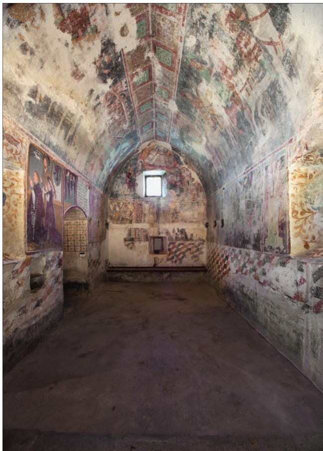
8. La cappella, prima del restauro, dopo la rimozione della cantoria. (Ph. Trossello)
