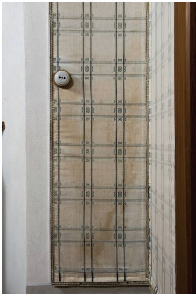
11. La parte bassa della parete perimetrale dopo il rimontaggio. (G. Gallarate)
