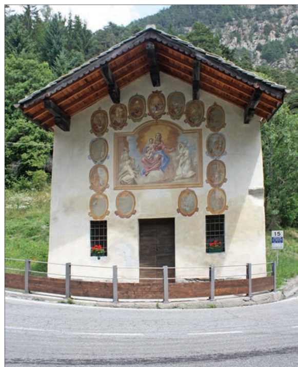
1. La cappella al termine dei lavori. (G. Sartorio)
