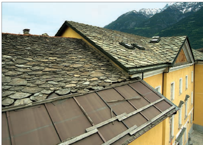
2. Particolare del tetto, falda ovest. (L. De Santis)
