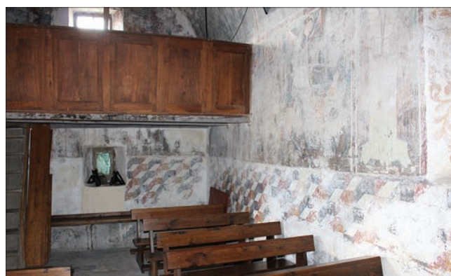
7. La cantoria, ora rimossa, prima del restauro. (N. Cuaz)
