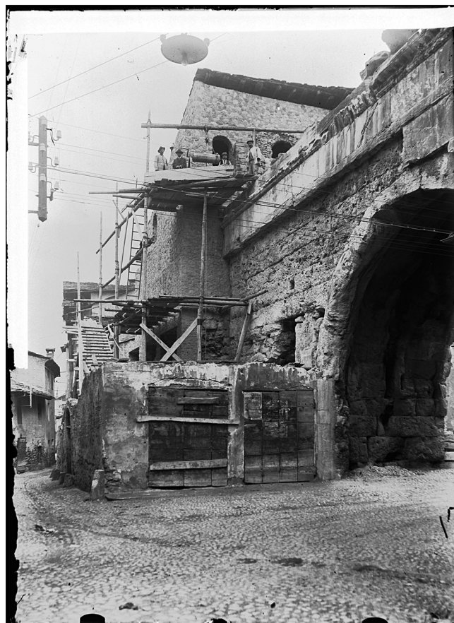
12. I lavori attorno alla torre laterale sud della Porta Prætoria. In basso, parzialmente demolita, la casa che si addossava al monumento. (Archivi beni archeologici)
