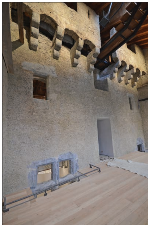
2. La facciata settentrionale del castello quattrocentesco riproposta al termine dei lavori di restauro. (A. Novel)
