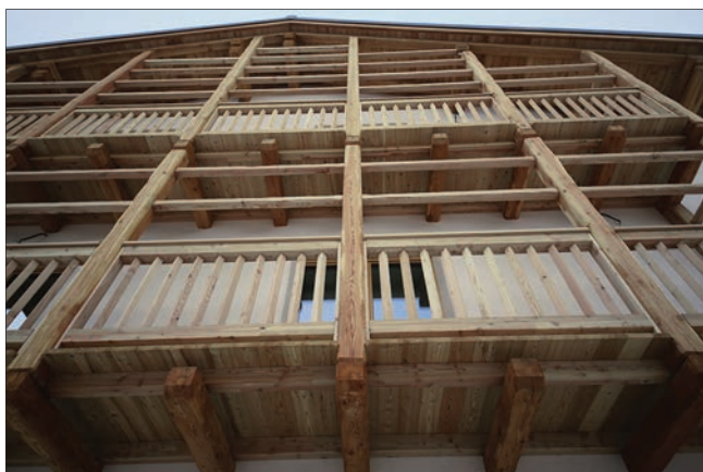
10. Sporthotel Rudolph. Balconi con lobbia in larice. (S. Stroppa)
