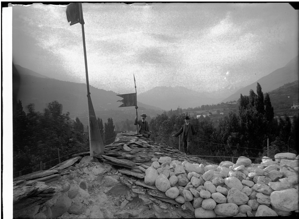
9. Ernesto Schiaparelli alla sommità dell'Arco d'Augusto durante i lavori di restauro. In primo piano il ciottolato di riempimento del tetto che è stato asportato. (Archivi beni archeologici)
