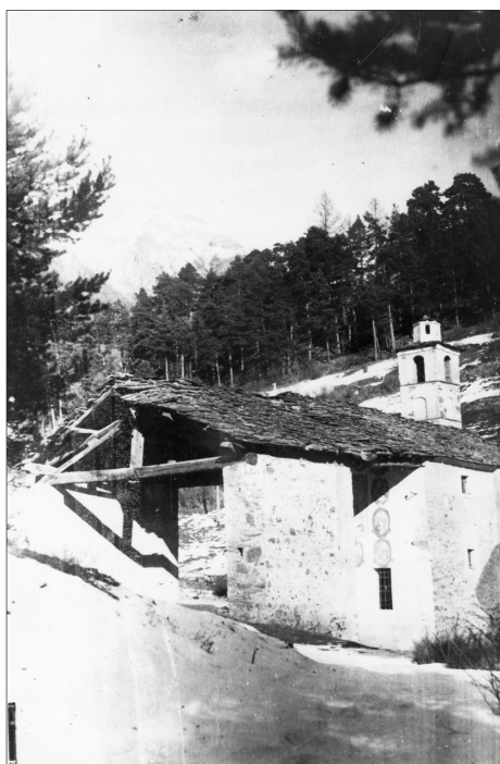
18. Il portico in facciata prima della demolizione. (Archivi catalogo beni culturali)
