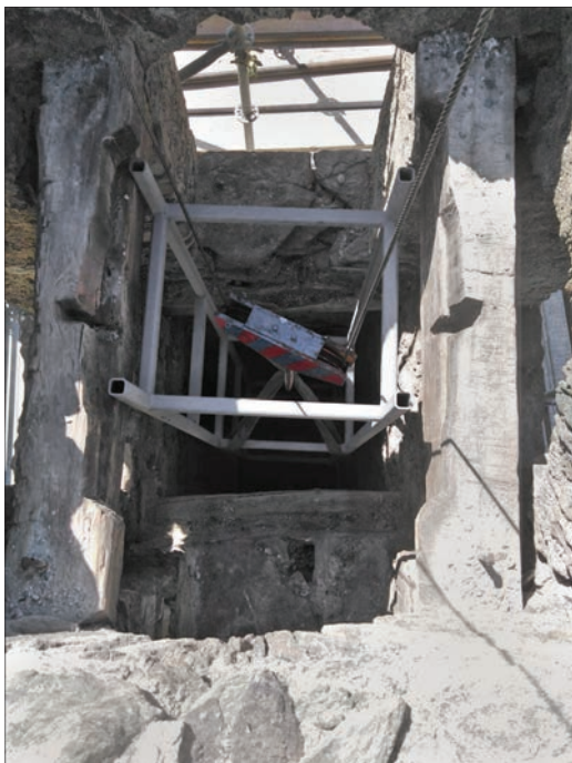
16a.-b. Inserimento del castelletto metallico per il rafforzamento del campanile. (S. Martino)
