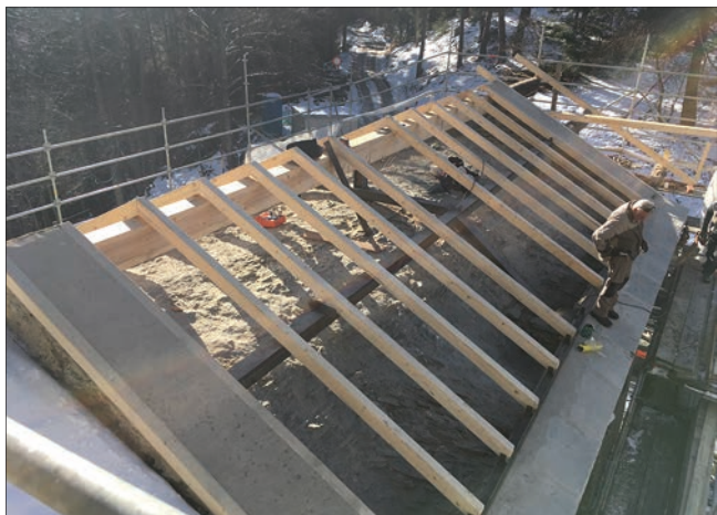
10. Orditura della nuova copertura in legno e metallo. (S. Martino)
