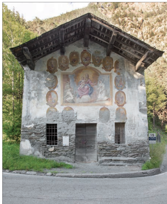
2. La cappella prima dei lavori. (P. Rosetta)
