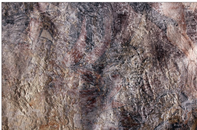
36. Registro inferiore, la bocca dell'infernale leviatano, dettaglio a luce radente del degrado inferto durante gli anni '70. (N. Cuaz)
