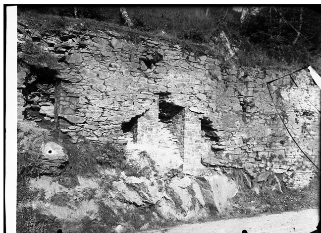
11. Sostruzioni della strada romana nel Comune di Arvier con i pilastri di sostegno fatti realizzare da Schiaparelli. (Archivi beni archeologici)
