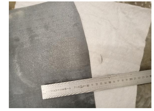
GMB EPDM intacte vs GTX percé GMB EPDM intatto vs GTX con fori
