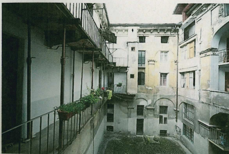
Corte, vista verso Ovest
