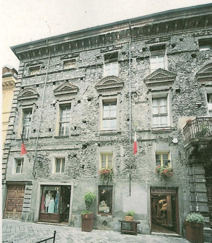
Fronte Nord, lato Est
