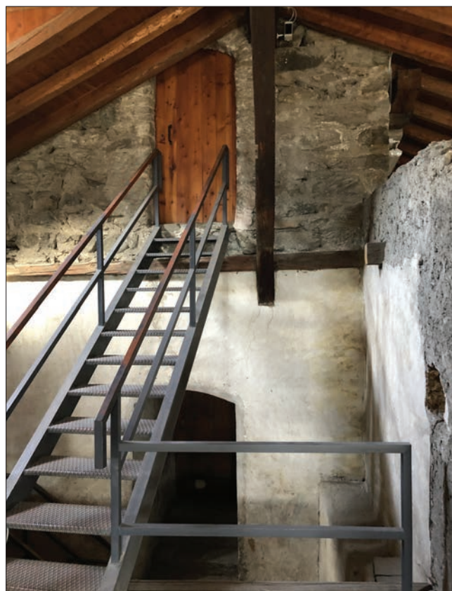
6a.-b. Scala metallica di salita al sottotetto e alla torre da sostituire. (Raggruppamento temporaneo professionisti)
