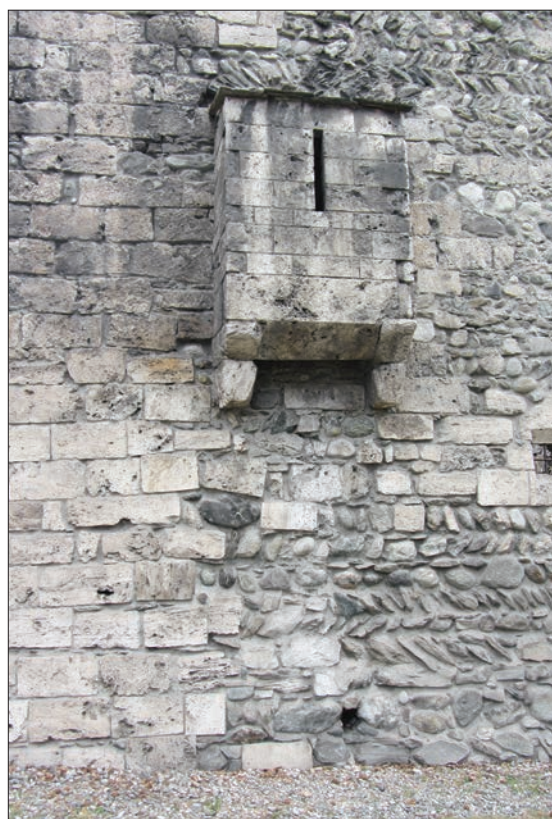
11. Rifacimento murario sotto la latrina pensile sulla facciata settentrionale. (M.C. Fazari)
