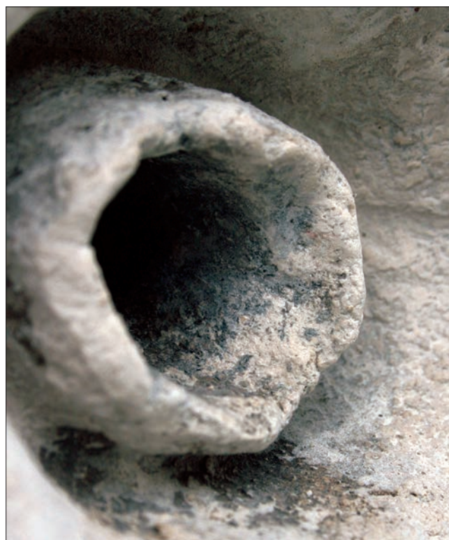
11. Dettaglio del colore originale composto da nero di carbone e calce spenta in fossa, all'interno del pistillo di un fiore. (N. Cuaz)
