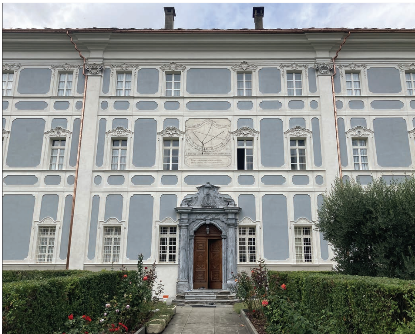
1. Particolare della facciata del Seminario maggiore al termine del restauro. (L. Pizzi)
