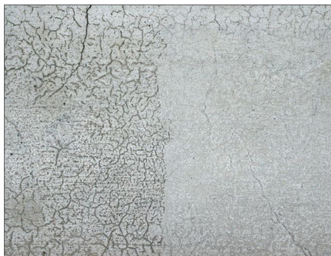
25. Stesura della pastina "a rasare" finalizzata alla chiusura di tutte le cavillature esistenti. (N. Cuaz)
