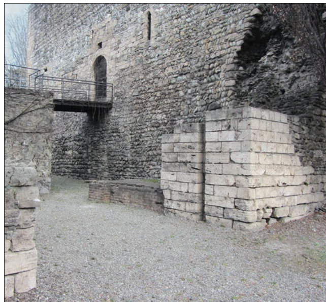
4. Sistemazione attuale dello scavo. Sulla destra è visibile lo stipite est della fauce della porta, con la scanalatura per la cateratta ( saracinesca ). (M.C. Fazari)
