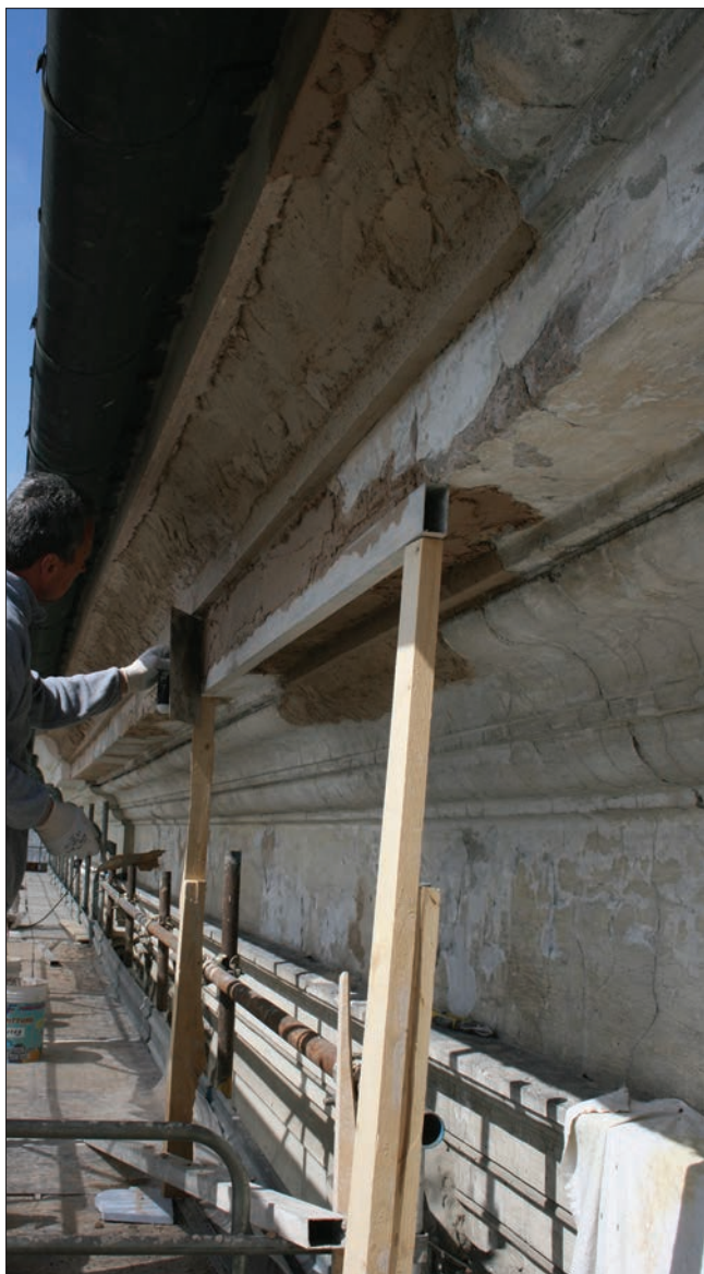
22. Ricostruzione del cornicione. (N. Cuaz)
