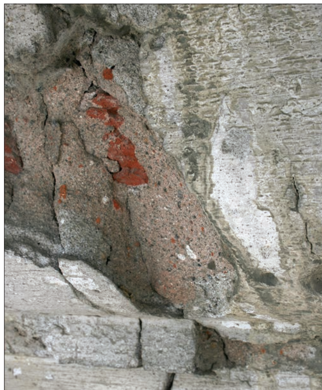
9. Tecnica esecutiva con impiego di malta di rinzaffo addizionata di cocciopesto. (N. Cuaz)
