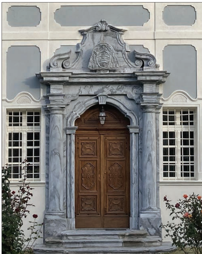
11. Il portale al termine del restauro.
