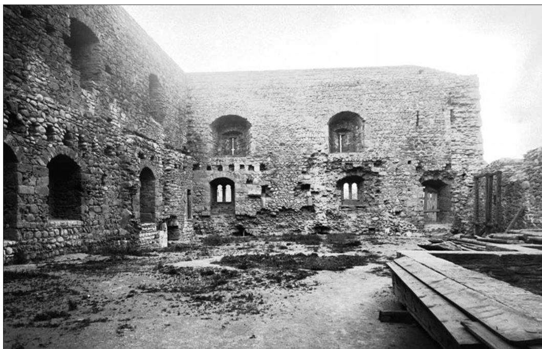
17. Il lato interno orientale dopo lo stamponamento delle finestre nel 1936. (Archivi beni archeologici SBAC)
