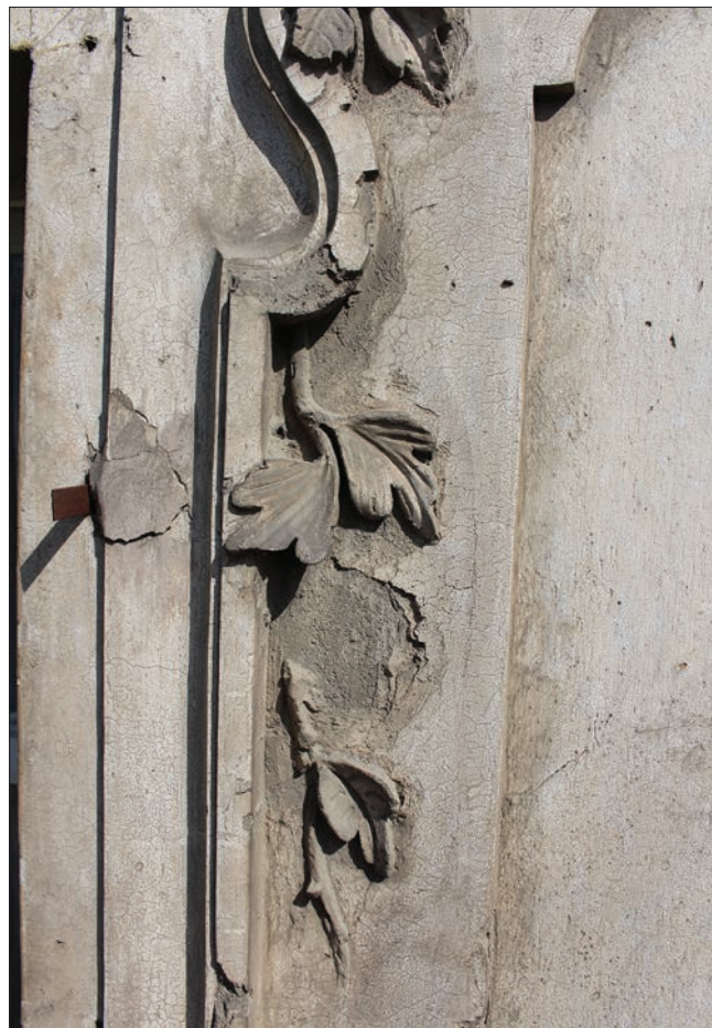
8. Dettaglio dei racemi a fogliette che ornano le cornici dei piedritti delle finestre nel terzo registro. (N. Cuaz)
