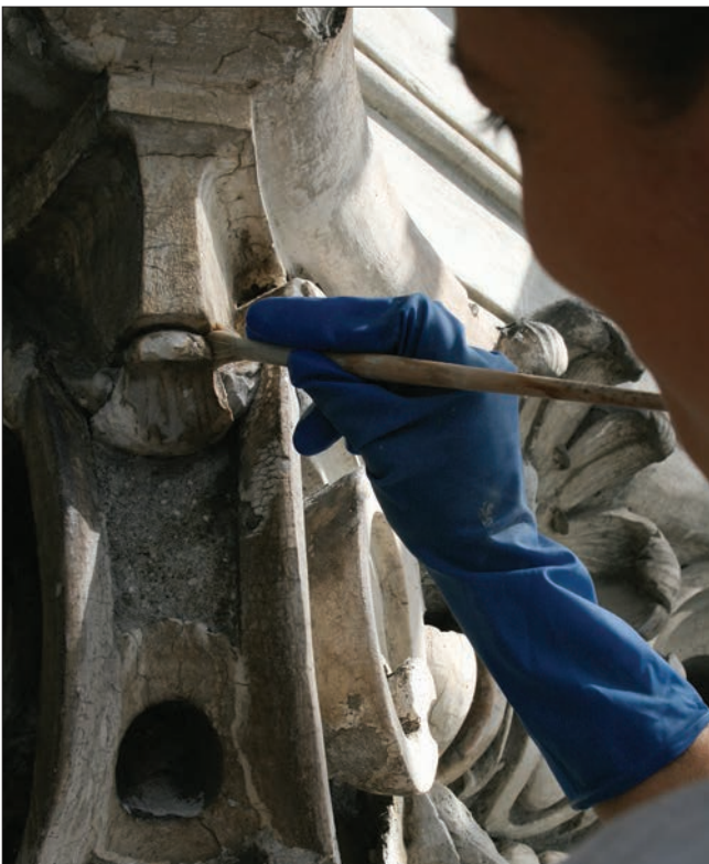
19. Pulitura mediante spazzolatura dopo applicazione dell'impacco. (N. Cuaz)
