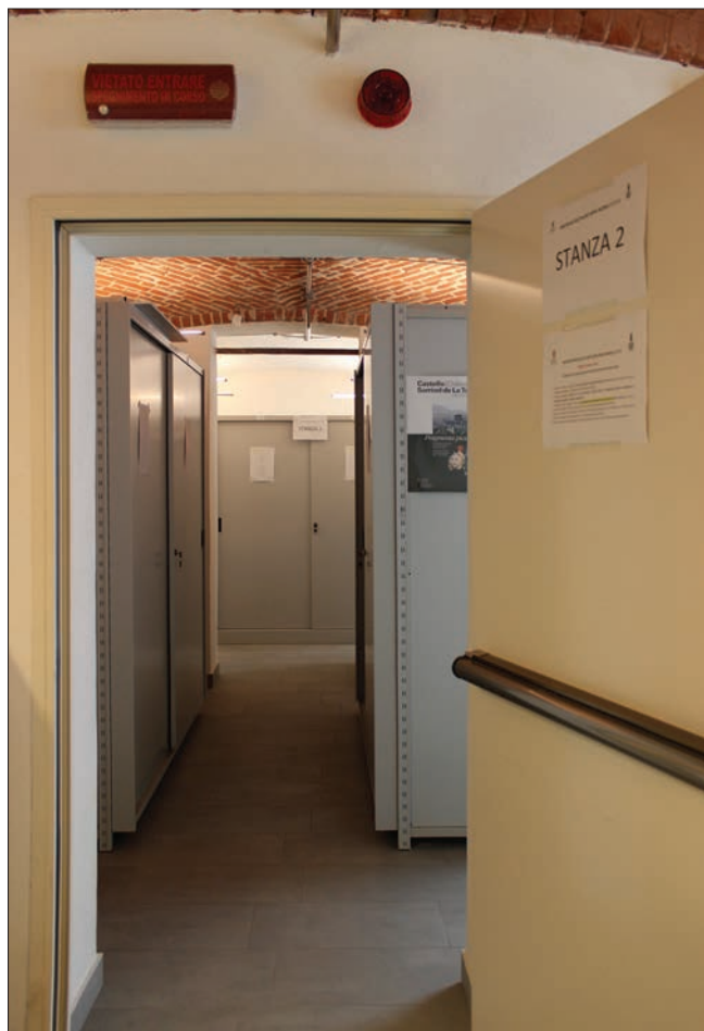
1. Veduta d'infilata dei locali archivio al piano terreno di Palazzo Lostan. Si notino le dotazioni di sicurezza (Porta REI 120 e impianto antincendio) e la cartellonistica. (M.J. Grange)
