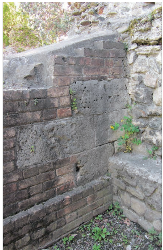
13. Particolare del restauro in cotto non mimetico della Porta Principalis Dextera. (M.C. Fazari)
