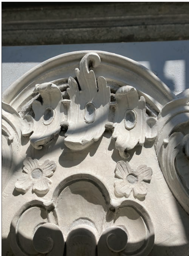
30a.-b. Dettagli della decorazione a stucco della facciata al termine del restauro. (L. Pizzi)
