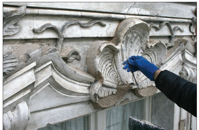
21a.-b. Ricostruzione tridimensionale delle parti lacunose. (N. Cuaz)
