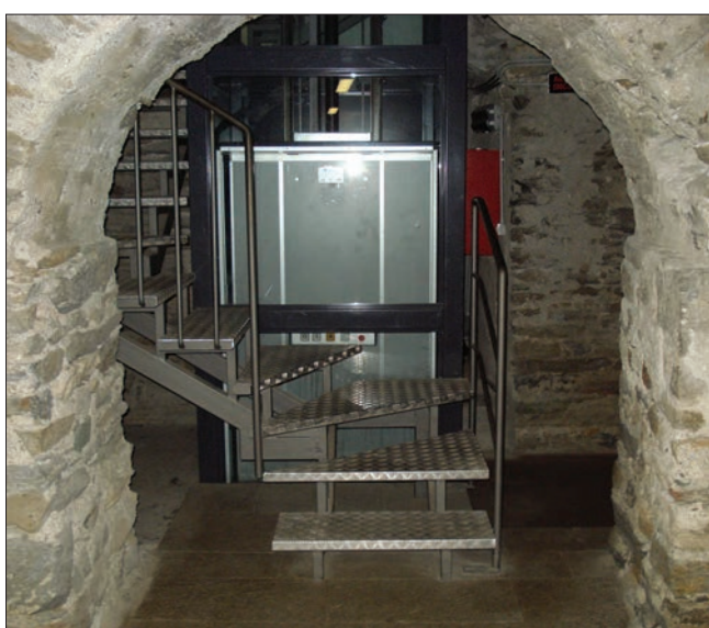
3. Sbarco scala e montascale al piano terra. (Raggruppamento temporaneo professionisti)
