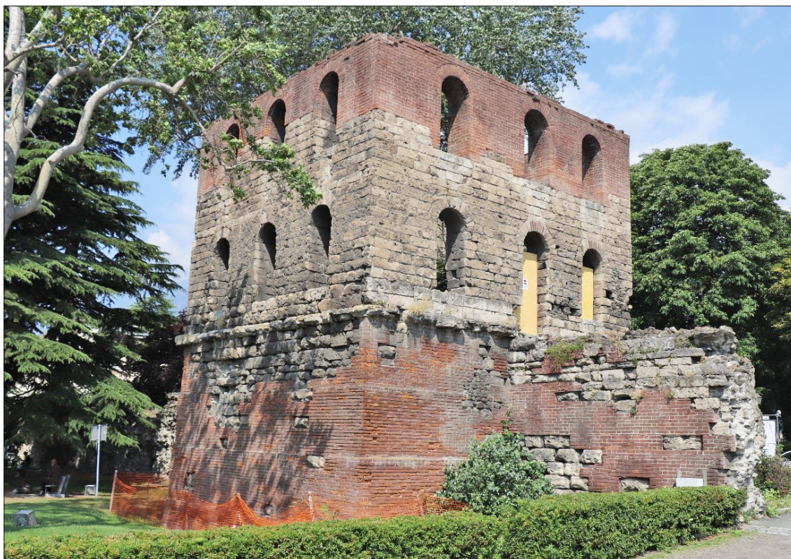
1. La Tour du Pailleron, vista angolo sud-ovest. (N. Dufour)
