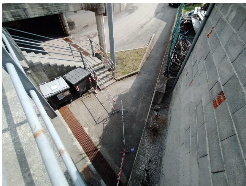
Figura 2.3: Vista da monte dell'area in cui verrà realizzata la nuova cabina.
