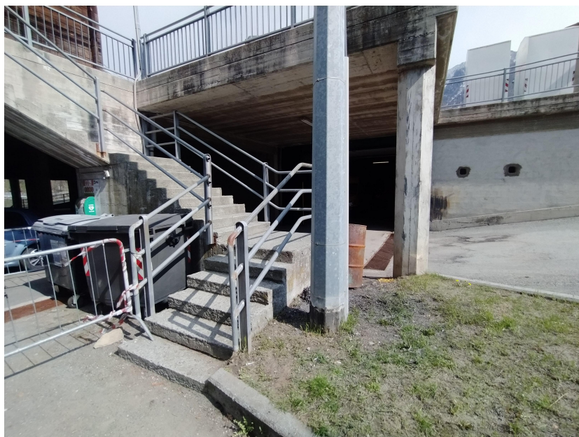
Figura 2.4: La parte di rampa di scale composta dagli ultimi 6 gradini verrà rimossa per fare spazio alla cabina e sostituita con altri gradini rivolti verso destra.
