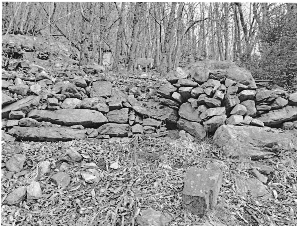
Fig. 4 – Muretto a secco.
