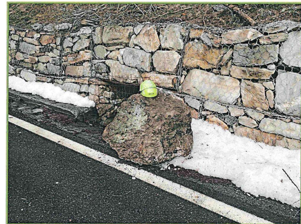
FOTO 3: particolare di un blocco arrestatosi sulla cunetta lato monte della sede stradale
