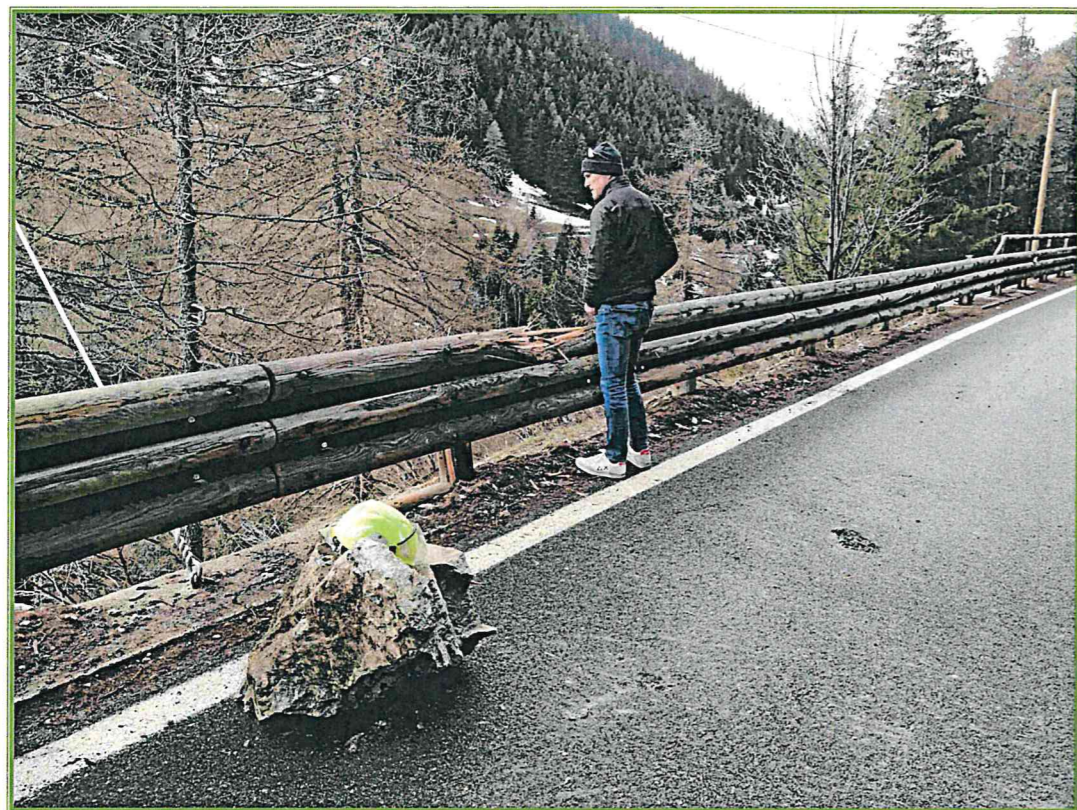
FOTO 4: vista di un altro blocco che si è arrestato nei pressi del sicurvia lato valle della strada
