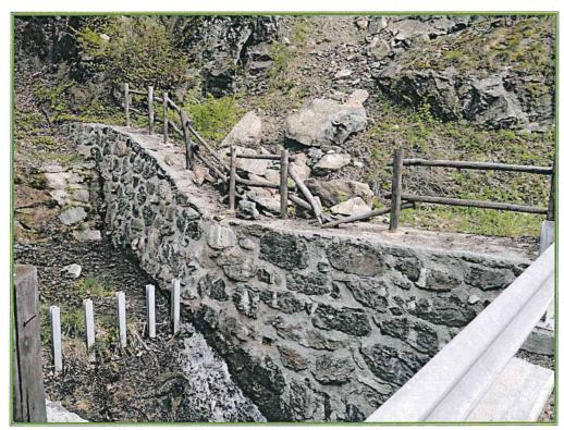
FOTO 4: vista del deposito del materiale lapideo crollato che si è arrestato in buona parte contro il parapetto esistente danneggiandolo
