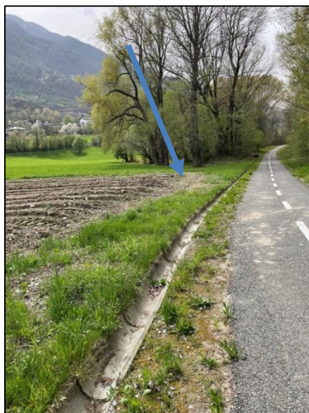
Figura 9: Ubicazione del primo palo di ammarro (freccia blu) per poter proseguire il cavidotto per via area.
