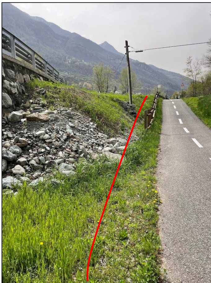
Figura 7: Punto in cui il cavo dritto costeggia il muro di valle della strada regionale: Evidente il palo che deve essere riposizionato ( Sezione 14 di progetto Tavola T03-Tavola T04).
