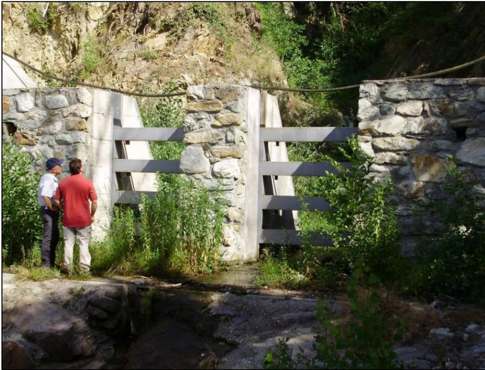
Figura 27: Briglia selettiva lungo il torrente Grand Val.
