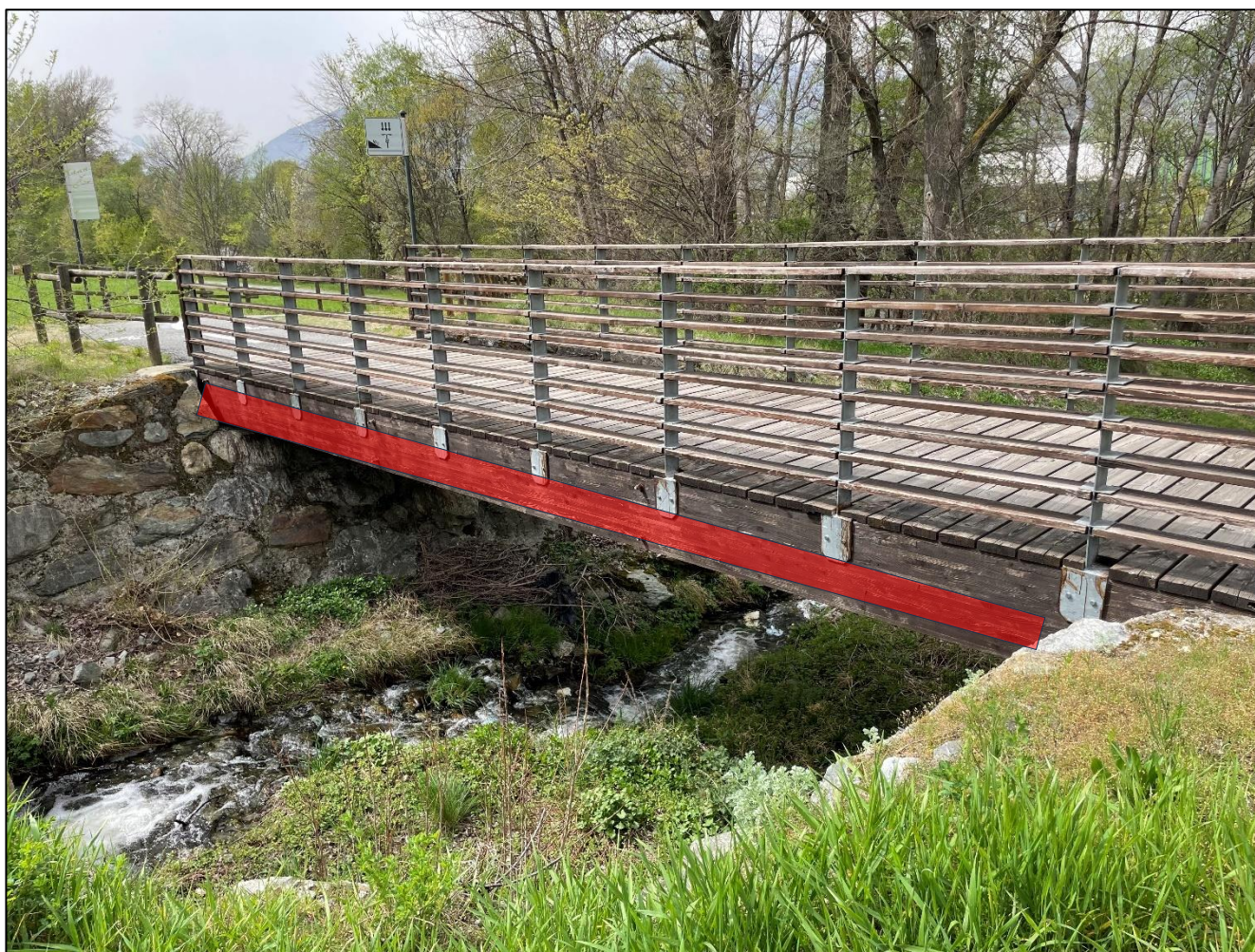
Figura 8: Ponte che attraversa il torrente Grand-Val, lato monte, dove verrà staffato il cavidotto (rappresentato dal poligono rosso).
