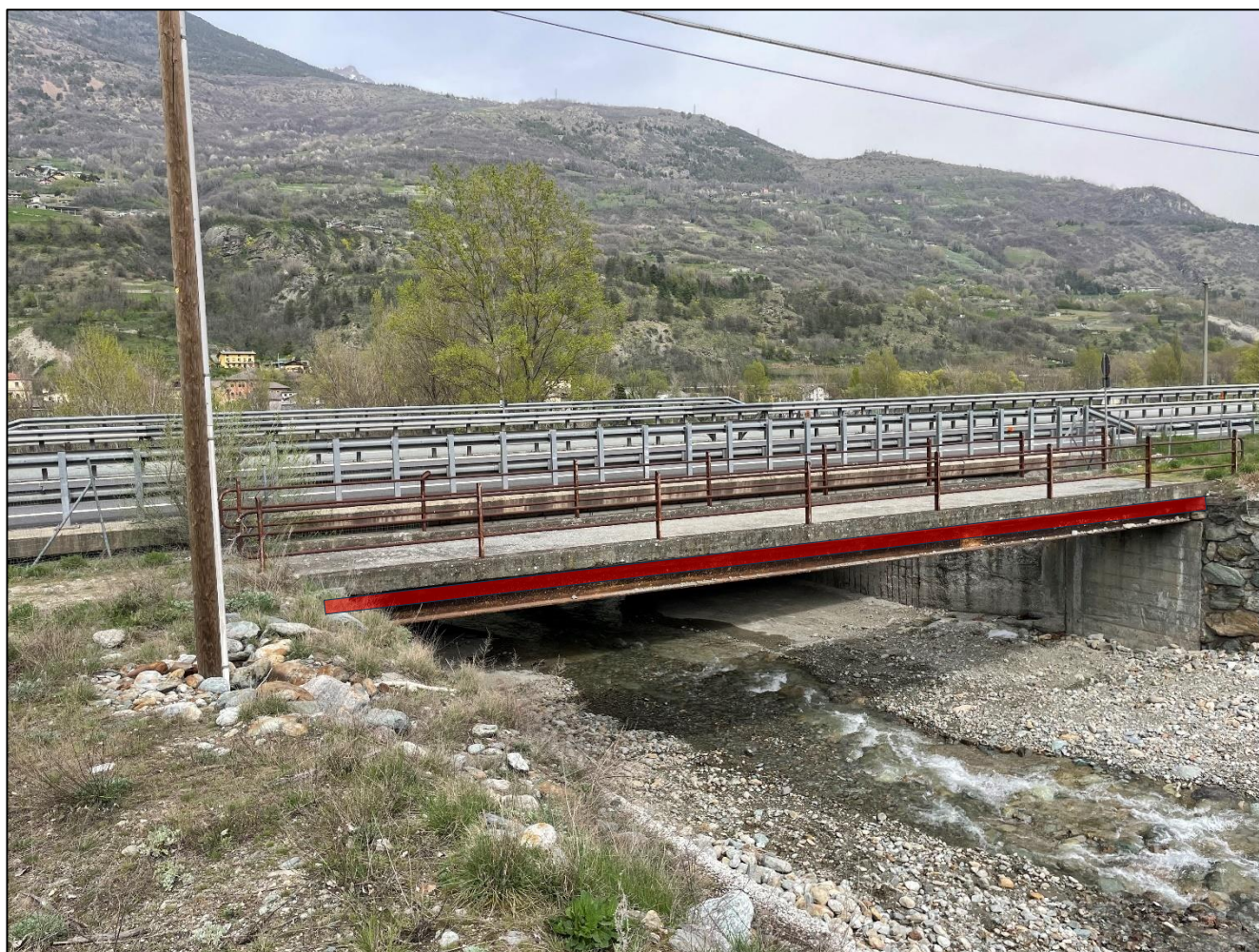
Figura 3: Ponte sul torrente Les Laures. Il cavidotto passerà lato monte, staffato ad esso. Nella figura, il cavidotto è raffigurato con il poligono rosso. (Sezione 2 di progetto Tavola T03-Tavola T04).
