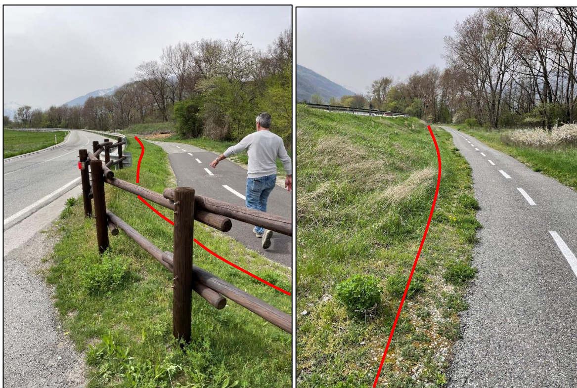
Figura 6: Punto in cui il cavidotto lascerà la strada regionale e verrà interrato al di sotto del settore prativo tra la strada e la pista ciclabile ( Sezioni 12-13 di progetto Tavola T03-Tavola T04)
