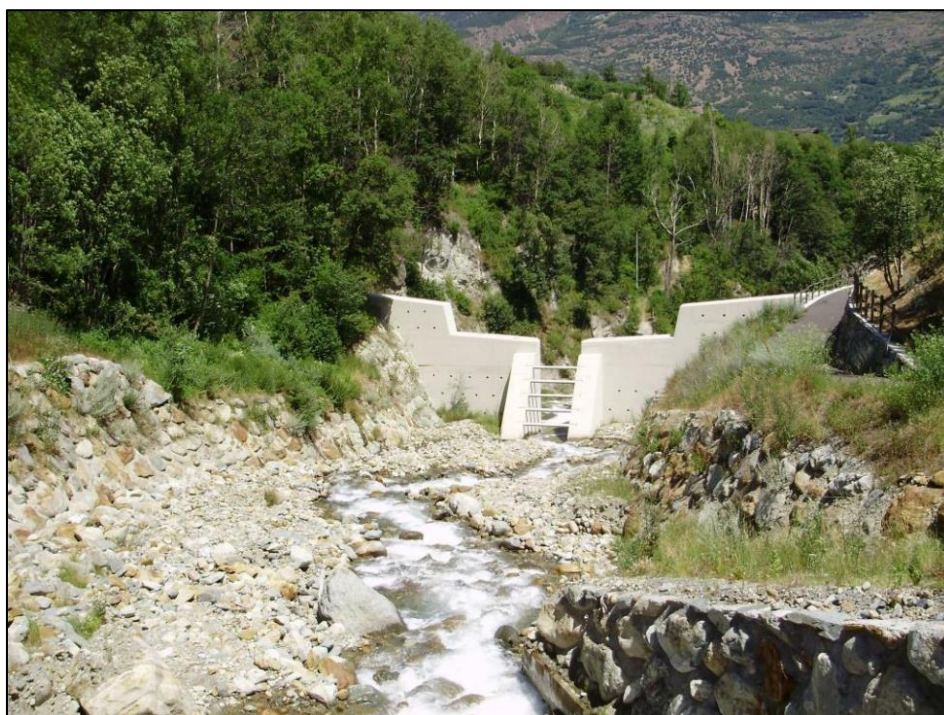
Figura 26: Vista da monte verso valle della briglia selettiva lungo il torrente Les Laures.
