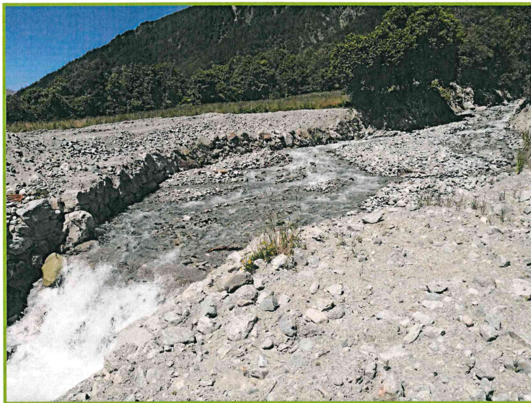
FOTO 1 : vista da valle del bacino della briglia in loc. Les Places con il filtro divolto
