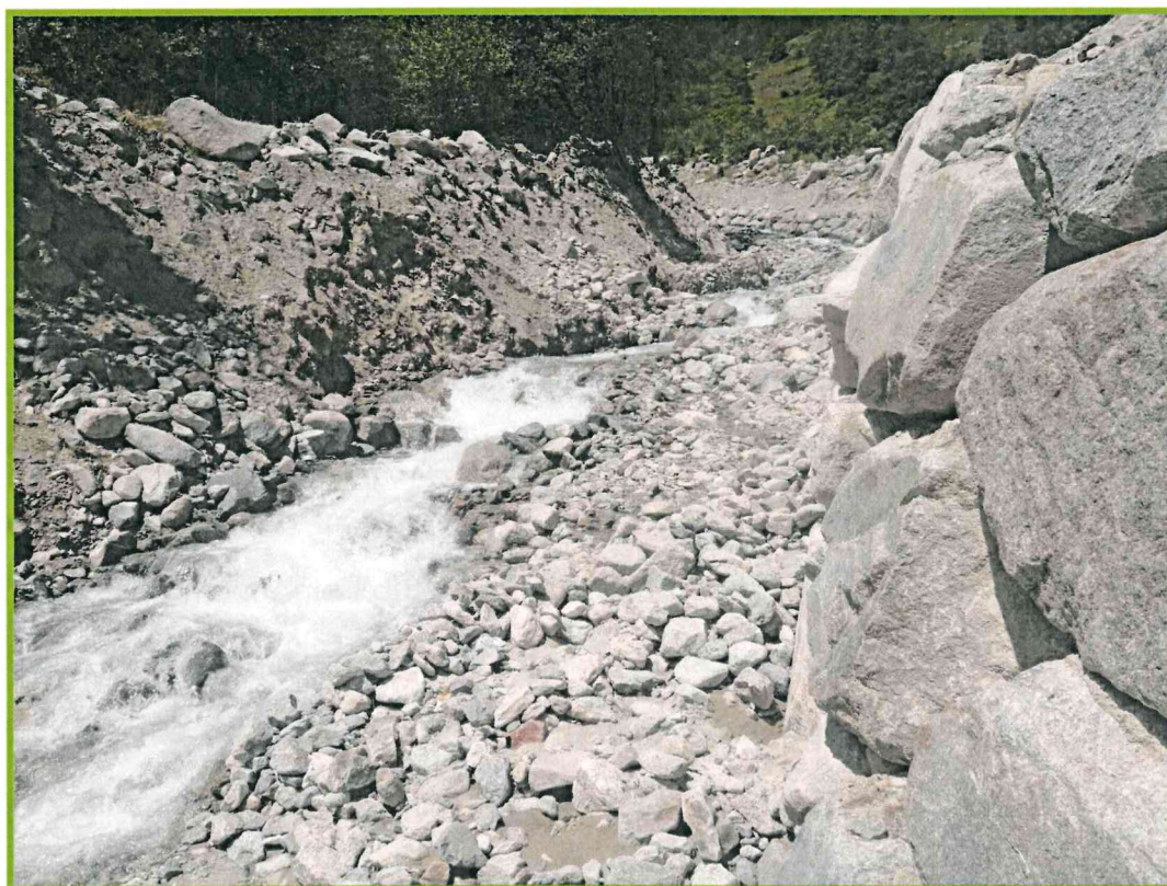
FOTO 2 : vista da valle del tratto di torrente a monte del bacino della briglia in loc. Les Places
