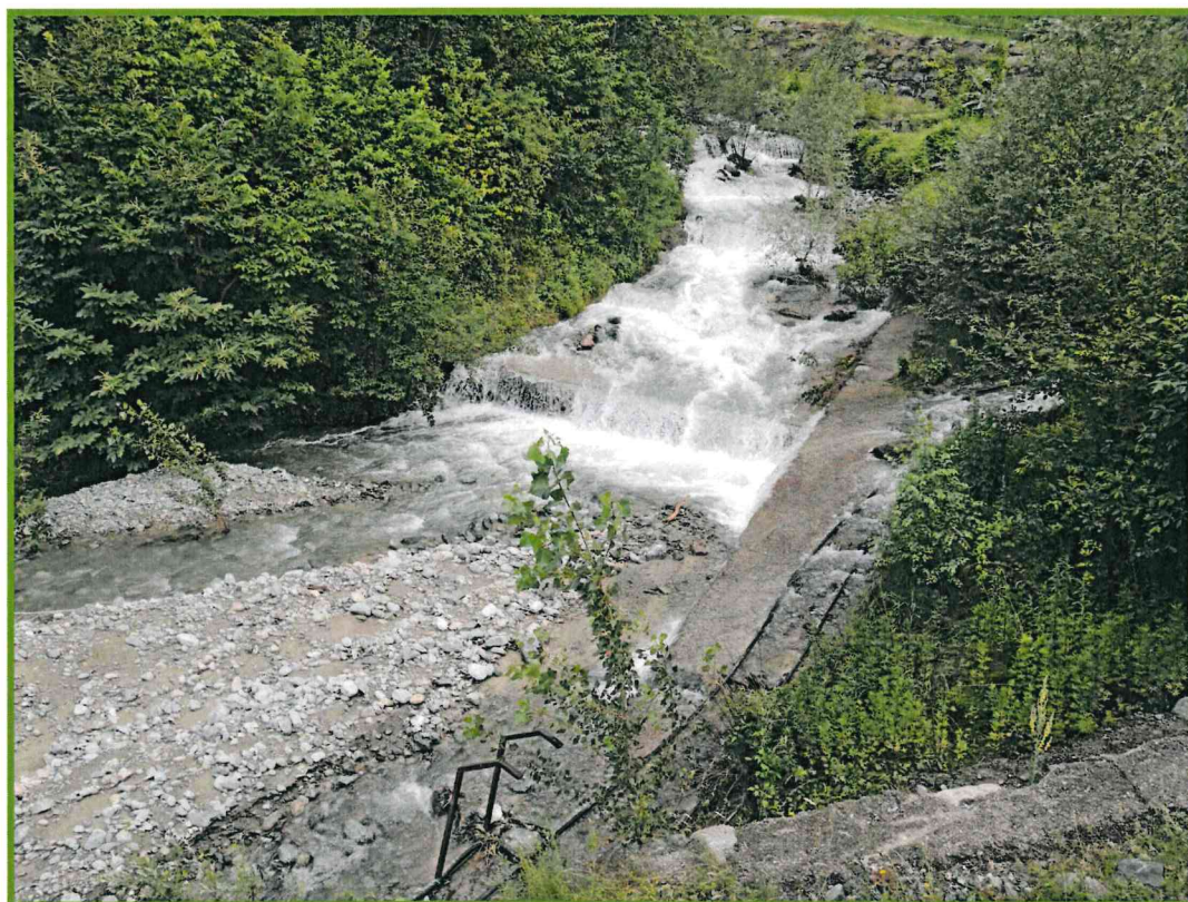
FOTO 4 : vista verso monte del bacino della briglia
