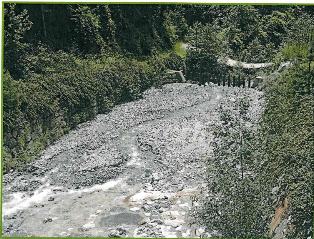
FOTO 5 : vista da monte del bacino della briglia 2
