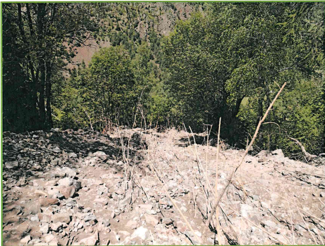
FOTO 3 : vista da monte verso valle del medesimo tratto di canalone/impluvio
