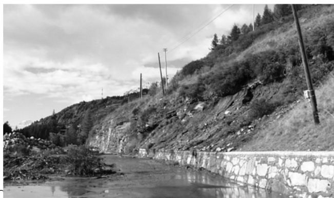
Figura 13 – Particolari fotografici del fenomeno di colata detritica censito al numero 33716 (sopra) e di colamento rapido censito al numero 25604 (sotto). I fenomeni hanno determinato accumulo di materiale sulla sede stradale.
