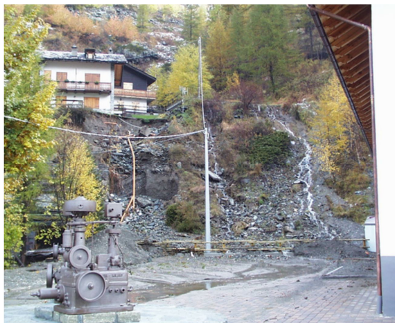
Figura 15 – Particolari fotografici del fenomeno di colata detritica censito al numero 18388 (sopra) e di colamento rapido censito al numero 25600 (sotto) che ha interessato la centrale Liconi, che sarà allacciata alla linea interrata in progetto.
