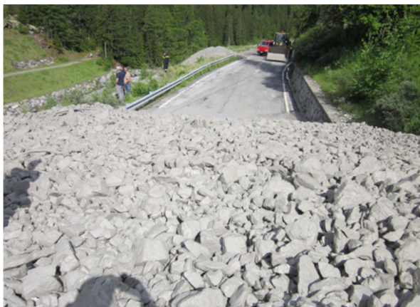
Figura 13 – Particolari fotografici del fenomeno di colata detritica censito al numero 33716 (sopra) e di colamento rapido censito al numero 25604 (sotto). I fenomeni hanno determinato accumulo di materiale sulla sede stradale.
