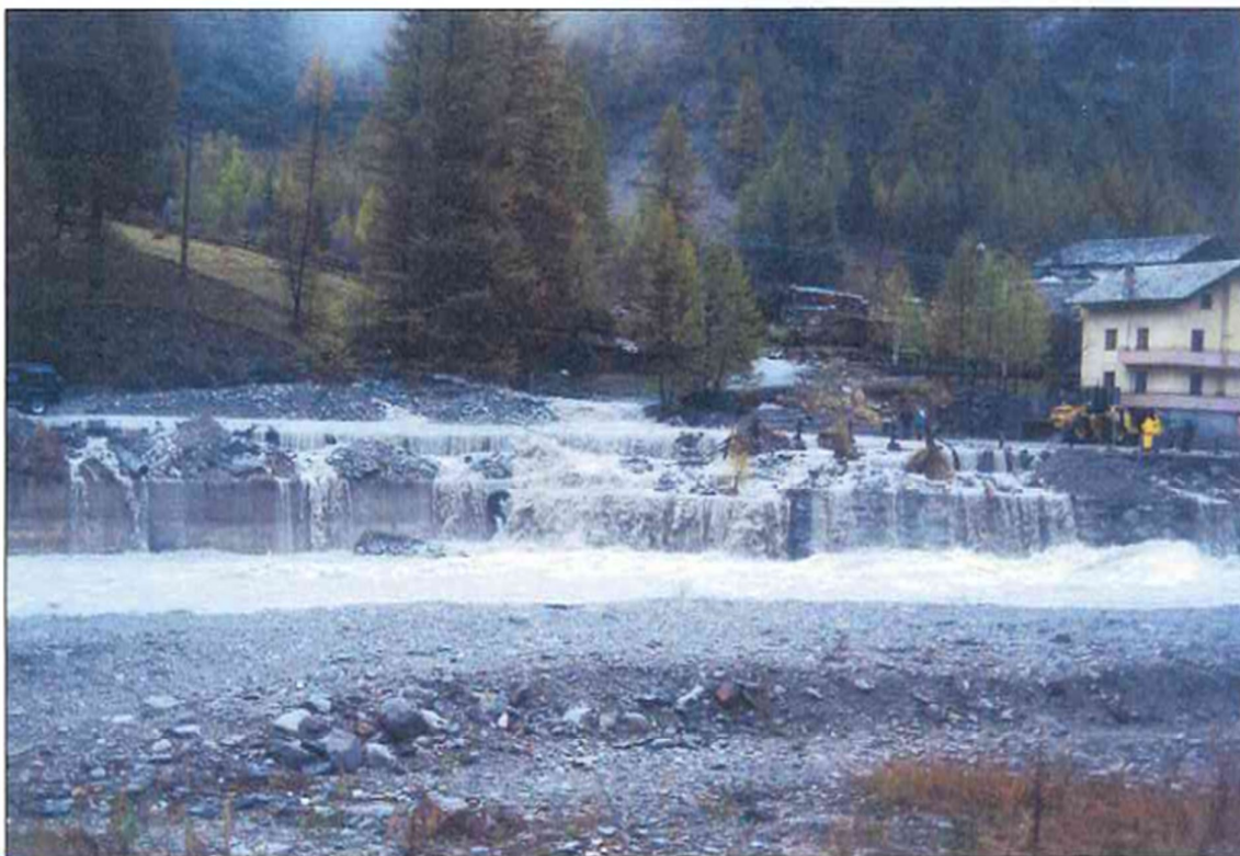
Figura 4 - Particolare dello sbocco del torrente Licony sull'Urthier. Si nota, in primo piano, la parte terminale del tubo di attraversamento della strada comunale ove scorreva il Licony e, in secondo piano, l'accumulo di materiale coincidente con il tratto iniziale del tubo
