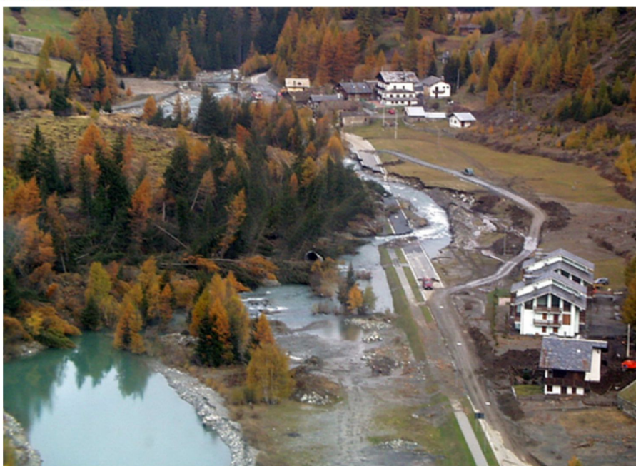
Esondazione del torrente Urtier causata dal fenomeno franoso in loc. Champlong che ha sbarrato totalmente l'alveo
