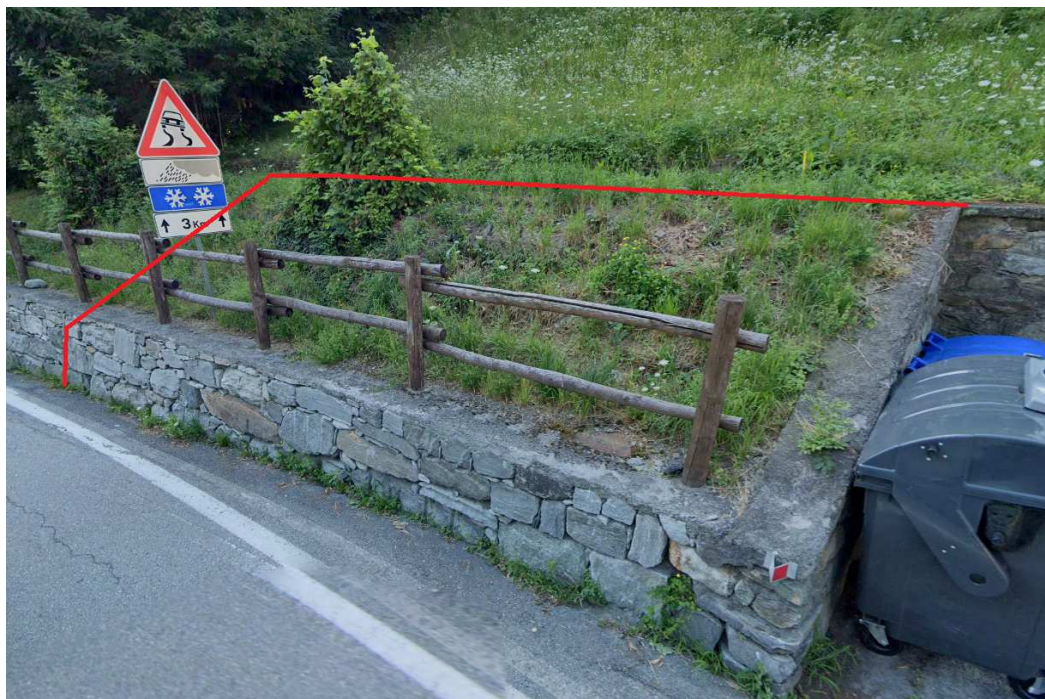
Foto n. 2: ubicazione della cabina
