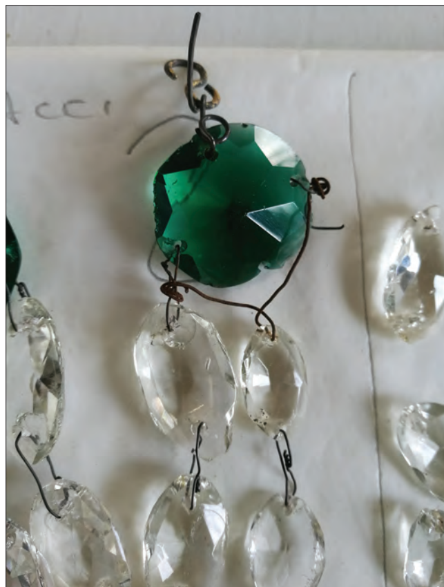
7. Lampadario n. 3: particolare dei vetri dopo la pulitura e prima della sostituzione delle vecchie legature.
