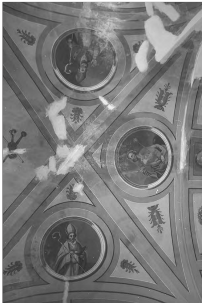
6a.-b. La decorazione pittorica delle volte, 1997. Sono evidenti i risarcimenti di intonaco, messi in opera, assai probabilmente, per contrastare il distacco di porzioni dipinte dal supporto murario. Queste due immagini sono state scattate nel corso di una campagna fotografica di censimento dei beni culturali promossa dalla Soprintendenza regionale.
