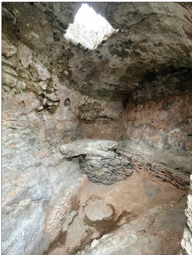
4. L'interno della cisterna dopo il restauro. (E. Quattrocchio)
