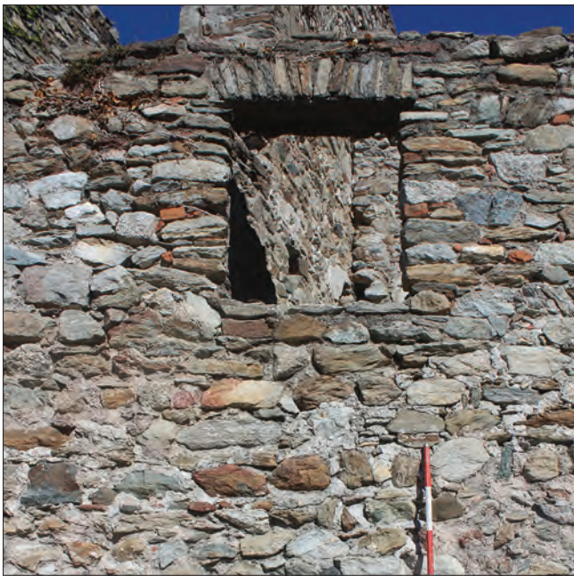
19. Una delle piccole finestre del fronte meridionale del corpo di fabbrica palaziale ricostruite nella campagna di lavori del 1965-1966. (S. Di Silvestre)
