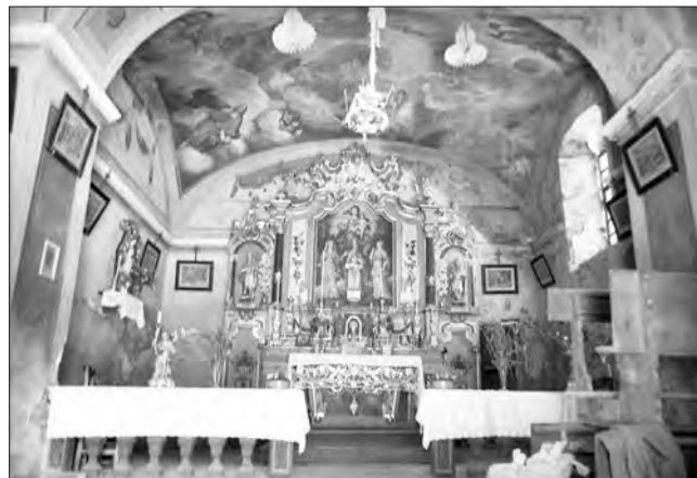
5a. Veduta del presbiterio all'inizio dei lavori. È palese il forte degrado degli intonaci, in particolare sulla parete perimetrale est e nell'angolo nord-est della volta, 1973.
