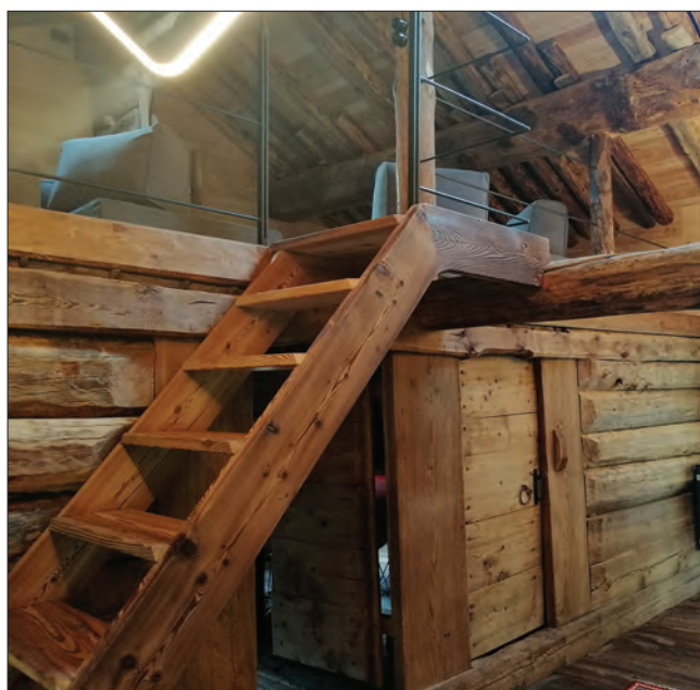
10. La nuova scala interna di collegamento tra i due livelli dello stadel. (A.M. Linty)
