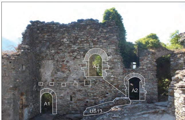
10. Il fronte est del nucleo residenziale. Nella parte inferiore si notano le due aperture verso il piano terra, in quella mediana l'apertura che conduceva al primo piano.
