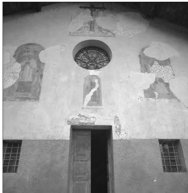
2. Dettaglio della decorazione pittorica della facciata all'inizio dei lavori, 1973.
