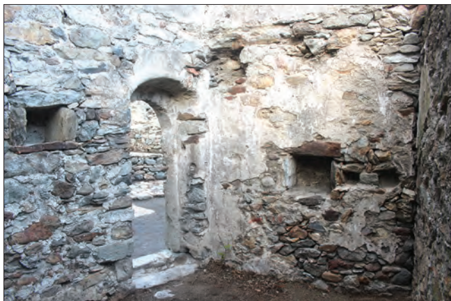
13. L'interno dell'avancorpo con la porta di accesso dopo il restauro. (S. Di Silvestre)
