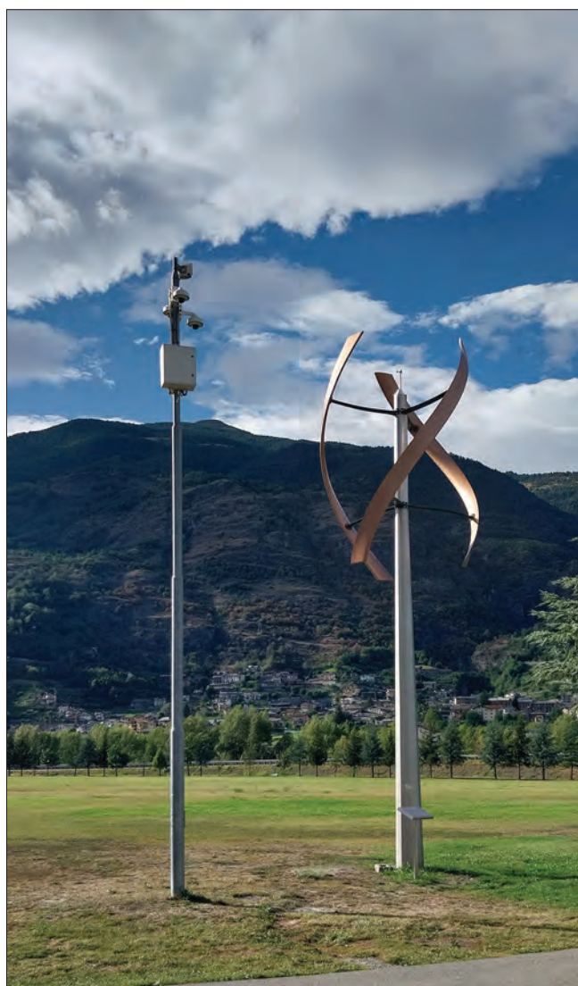
6. Gressan, area verde Les Îles: aerogeneratore ad asse verticale. (D. Martinet)
