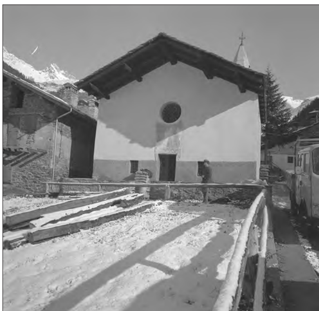
4. La cappella al termine degli interventi, 1974. (D. Prola)
