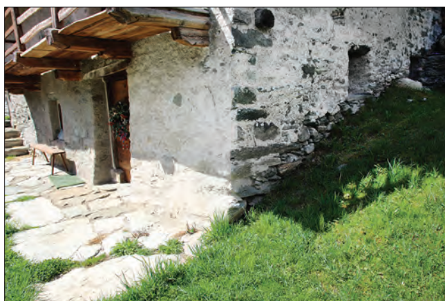
11. Particolare delle superfici esterne in muratura intonacate a calce raso pietra che hanno subito minimi interventi di risanamento finalizzati alla loro conservazione, senza ripristini che ne modificassero l'aspetto o cercassero di riportarlo a presunte situazioni originali. (D. Turcato)
