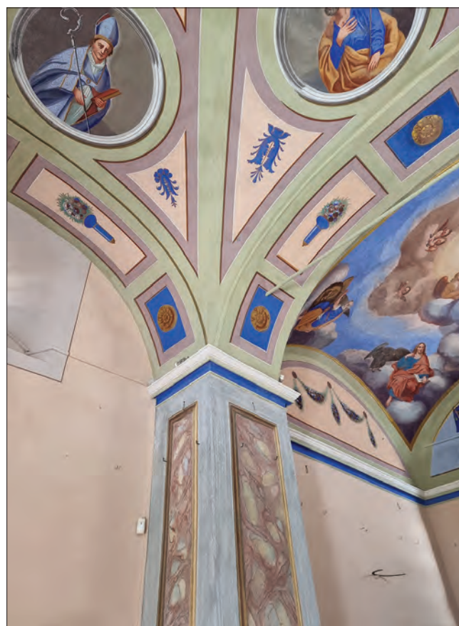
29. Scorcio delle volte dell'aula e presbiterio a restauro ultimato. (N. Cuaż)
