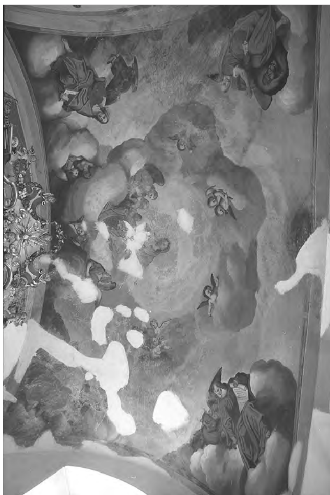
6a.-b. La decorazione pittorica delle volte, 1997. Sono evidenti i risarcimenti di intonaco, messi in opera, assai probabilmente, per contrastare il distacco di porzioni dipinte dal supporto murario. Queste due immagini sono state scattate nel corso di una campagna fotografica di censimento dei beni culturali promossa dalla Soprintendenza regionale.
