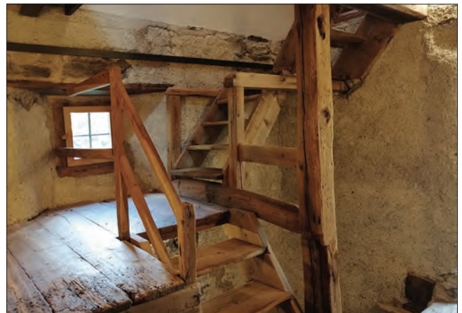
6-7. La scala interna di collegamento tra la porzione in muratura e la soprastante porzione in legno dell'edificio: com'era (a sinistra) e com'è oggi (in basso). (A.M. Linty)
