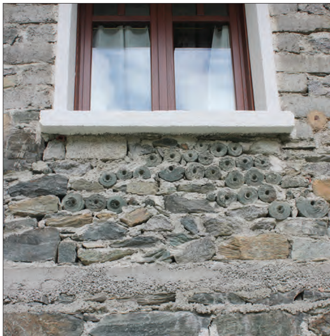
2. Particolare della parete di un edificio della frazione con gli scarti di tornitura reimpiegati nella muratura. (G. Sartorio)
