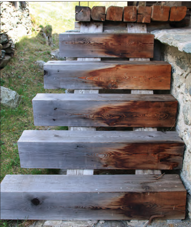
4. Fronte ovest, particolare della nuova scala di accesso all'ex fienile. (D. Turcato)
