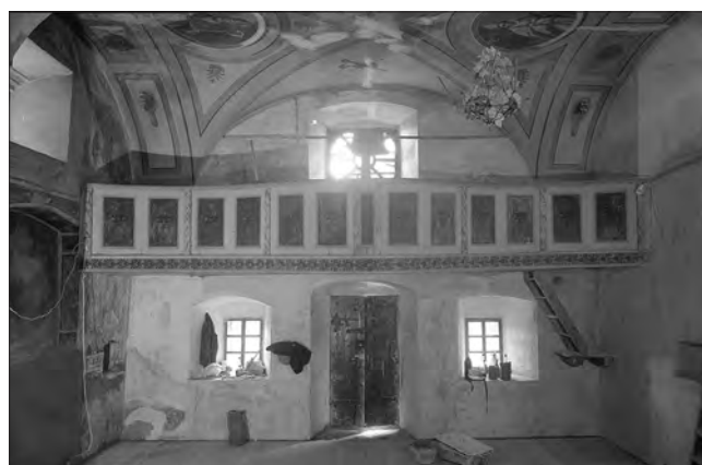
5a. Veduta del presbiterio all'inizio dei lavori. È palese il forte degrado degli intonaci, in particolare sulla parete perimetrale est e nell'angolo nord-est della volta, 1973.
