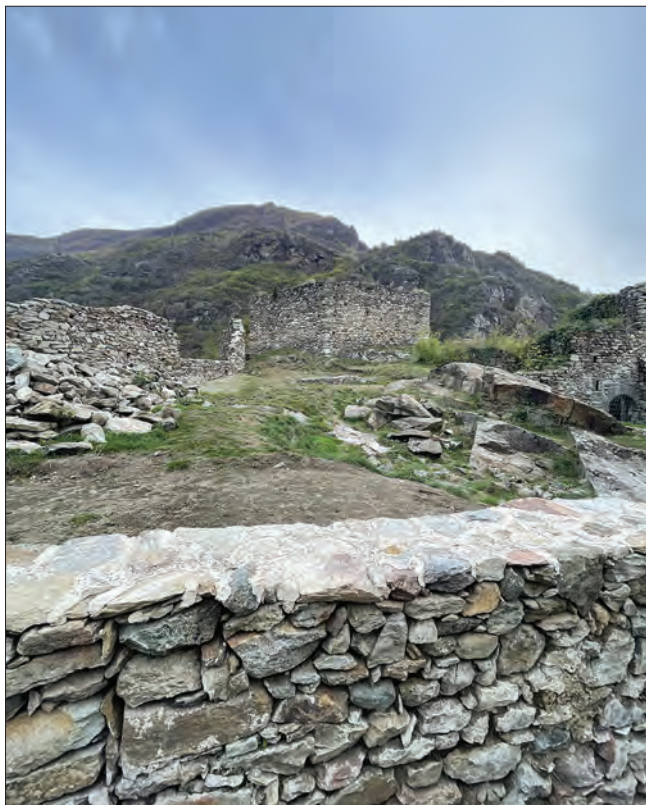
2. In primo piano la sistemazione della cresta del muro che divide la bassa corte dalla parte più alta. (E. Quattrocchio)
