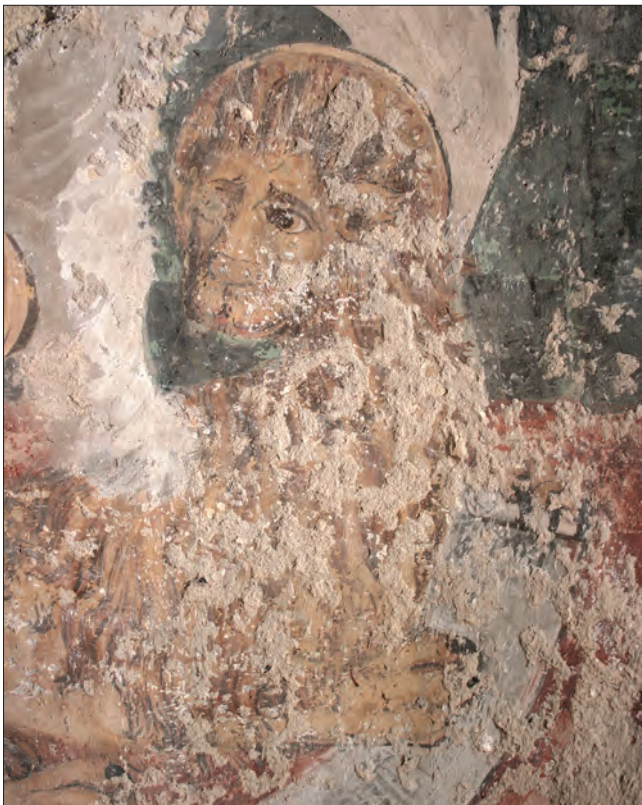
19. Degrado superficiale inferto dal descialbo degli anni Settanta. (N. Cuaz)
