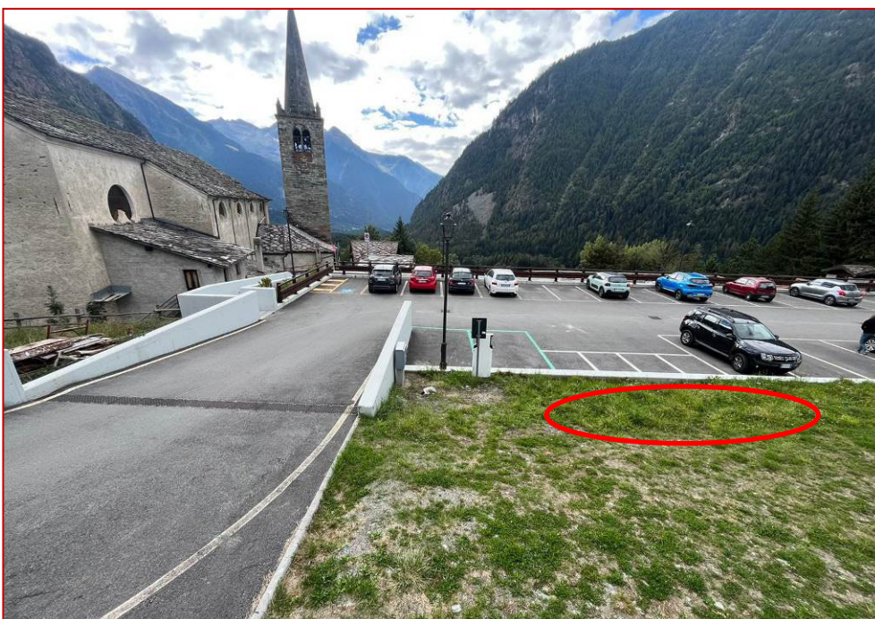
Fig. 5 - Vista da S e da N sull'area interessata dalla costruzione della cabina secondaria
