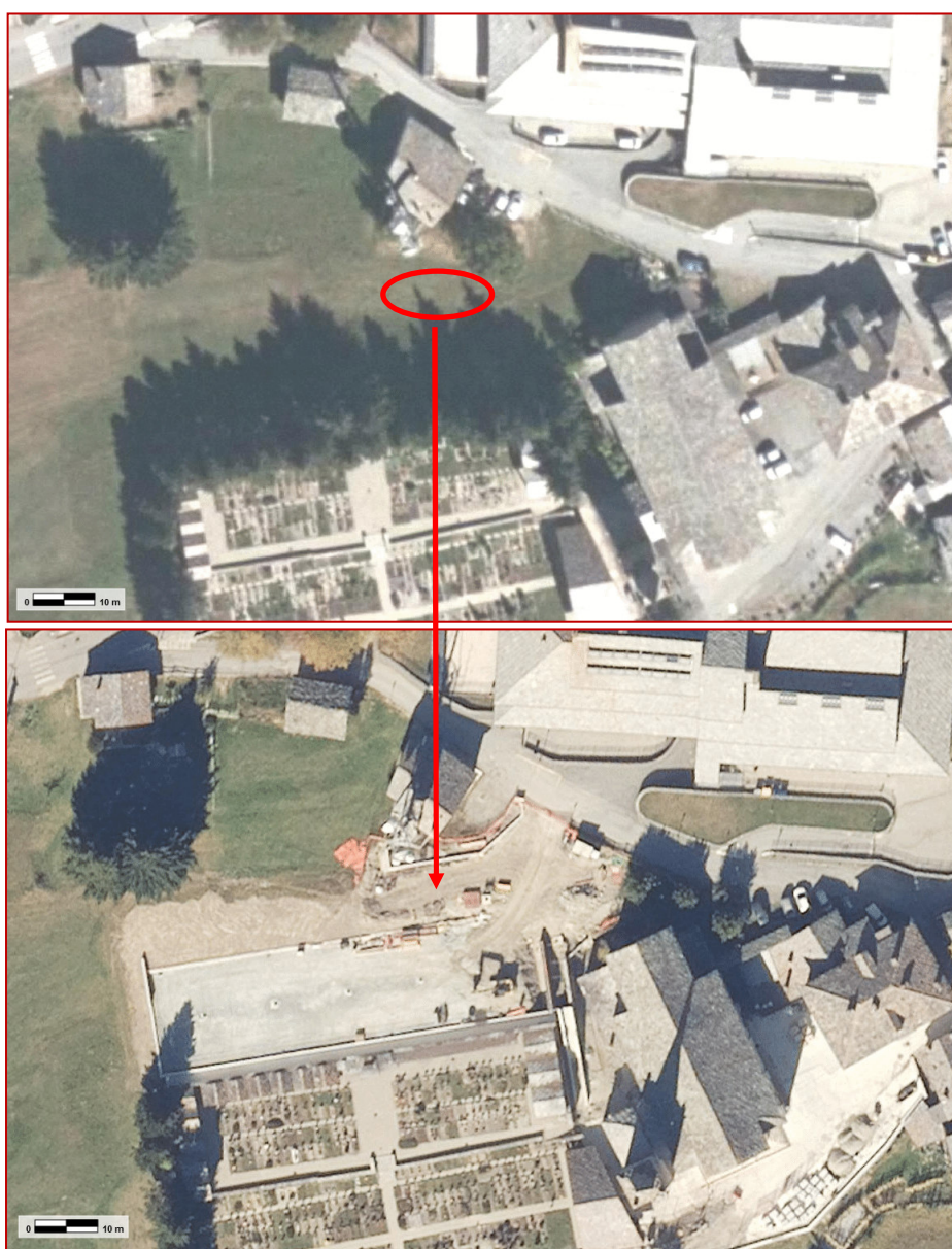
Fig. 9 - Confronto fotoaeree del 2018 (sopra) e del 2021 (sotto), con il rimodellamento dell'area interessata dalla realizzazione del parcheggio comunale (Geoportale RAVA)
