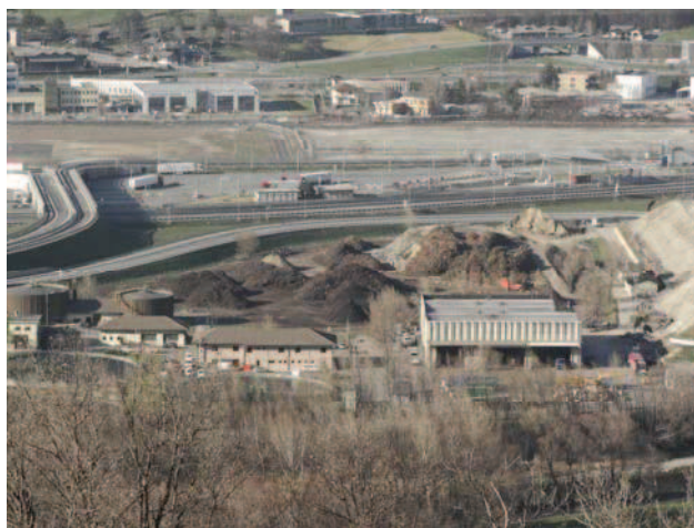
Fig. 45 - L'impianto di compostaggio
