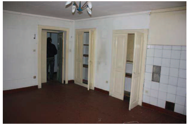
Piano rialzato - Particolare serramenti interni e ante ripostigli.
