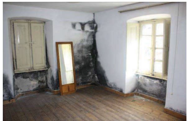
Piano primo – alloggio est – vista delle ante interne.
