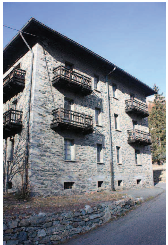
Vista del prospetto sud-est
