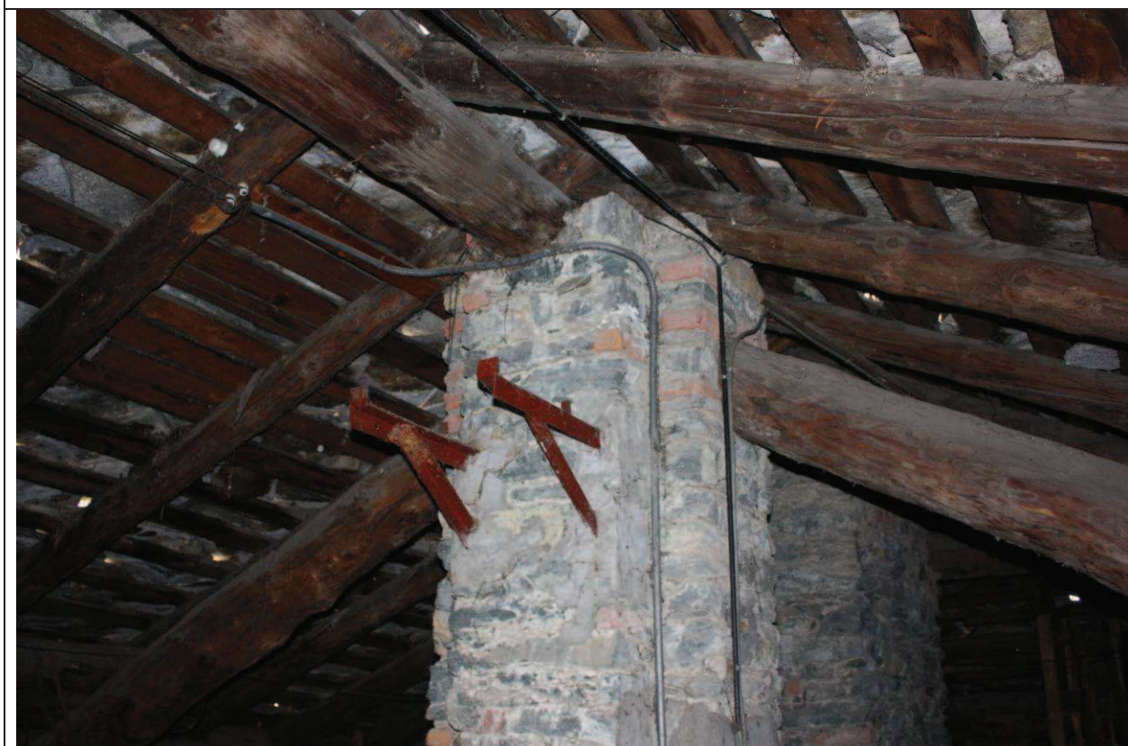
Sottotetto – vista dei due pilastri che sorreggono la copertura a padiglione.
