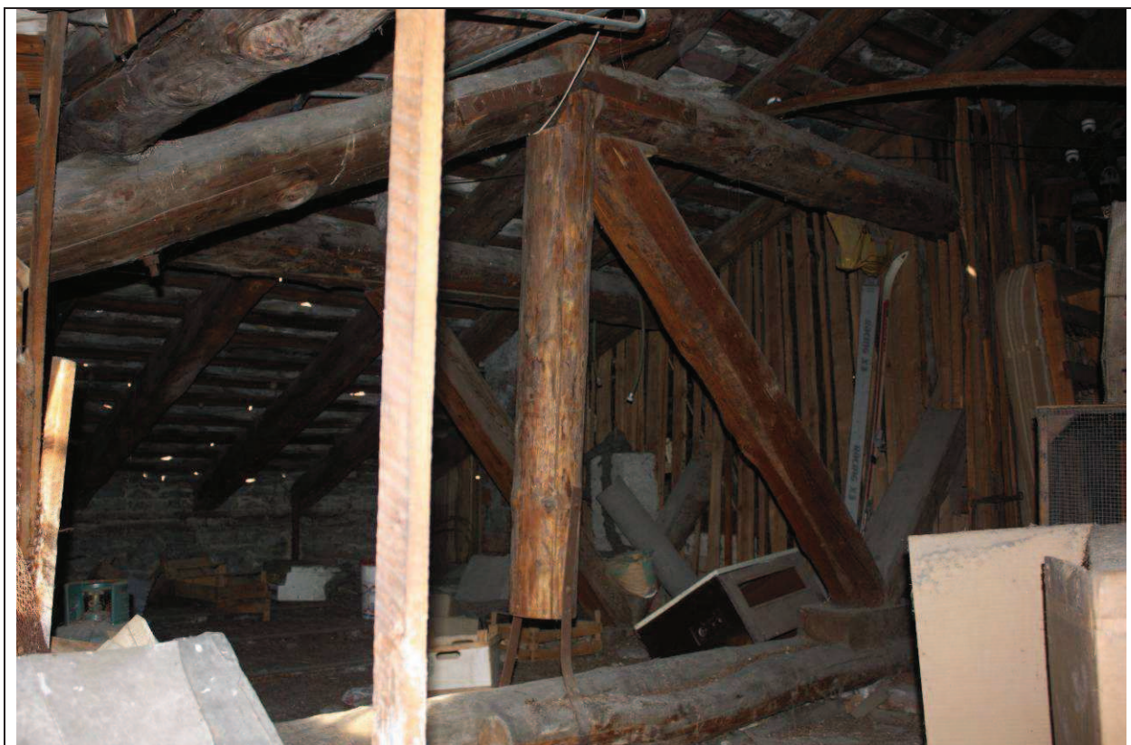
Sottotetto - Particolare della struttura del tetto a padiglione.
