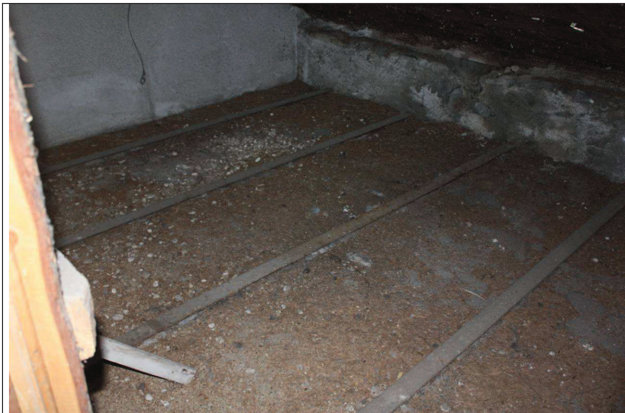
Sottotetto – Vista del solaio non pavimentato realizzato in laterizio e putrelle d'acciaio.
