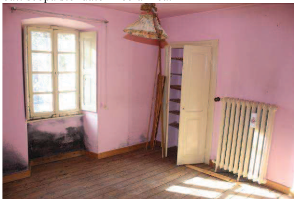
Piano primo – alloggio est – vista interna dei serramenti e del termosifone.
