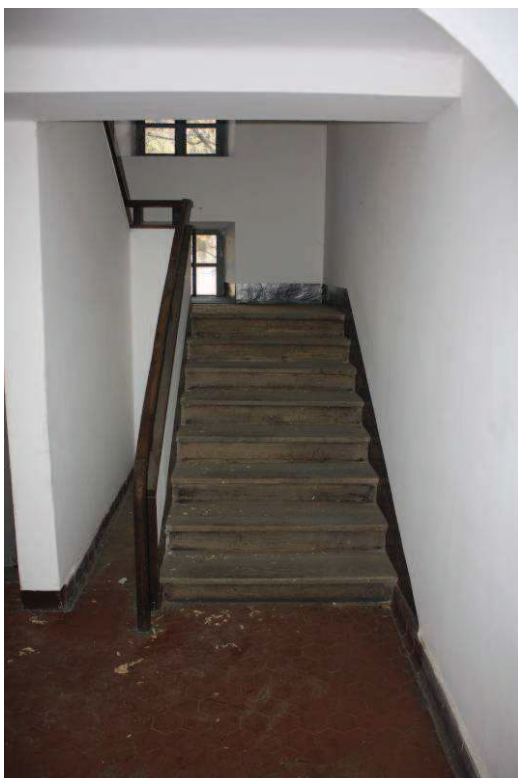
Piano rialzato - Vista della scalinata interna.
