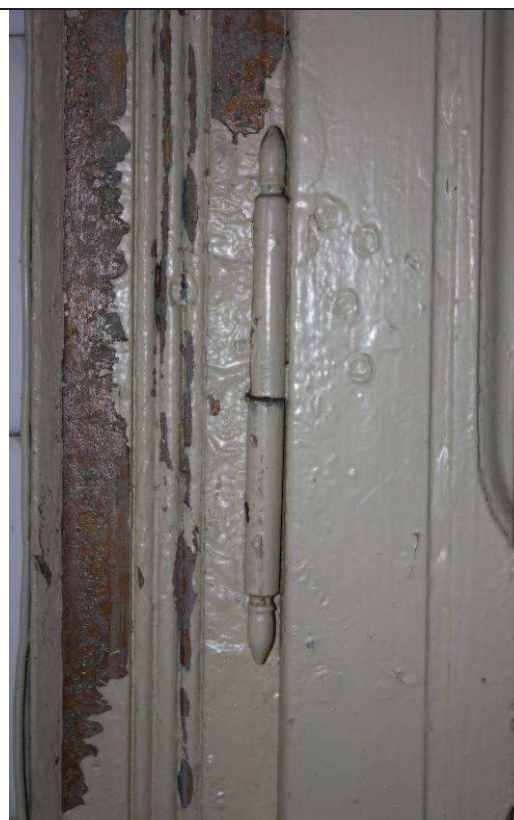
Piano rialzato – particolare della cerniera di una porta interna
