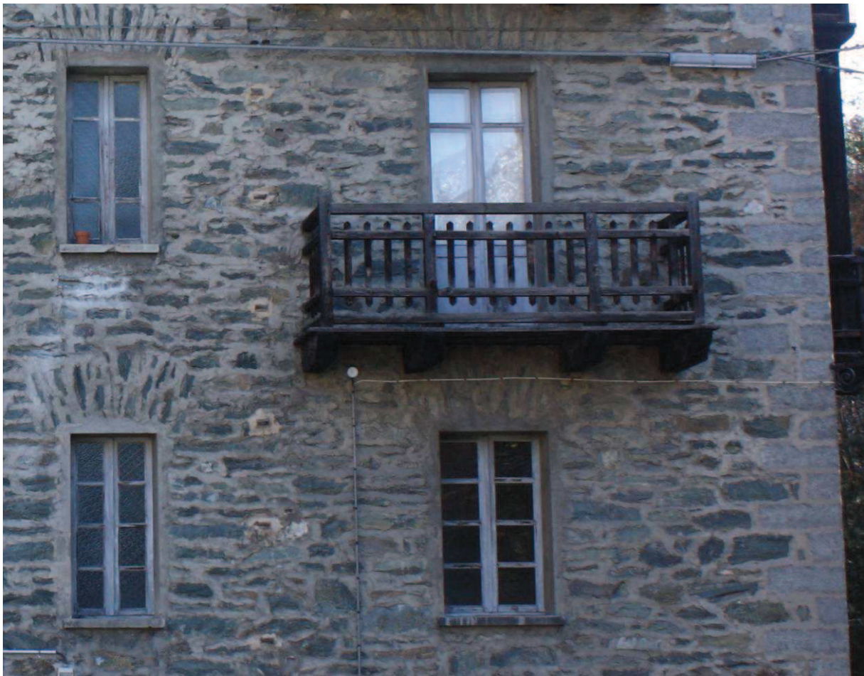
Vista in dettaglio delle aperture, con architrave arcuata in pietrame, serramenti a specchiatura multipla, balcone ligneo e cantonali in blocchi di pietra regolari.
