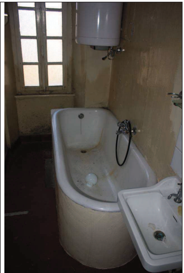
Piano rialzato – alloggio est – particolare dei servizi igienici.
