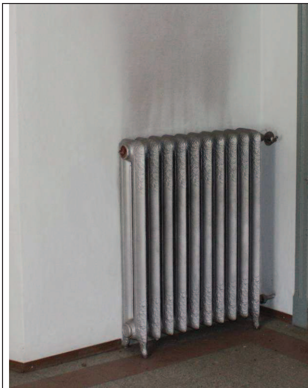
Piano secondo alloggio est – particolare del calorifero in ghisa stampata.
