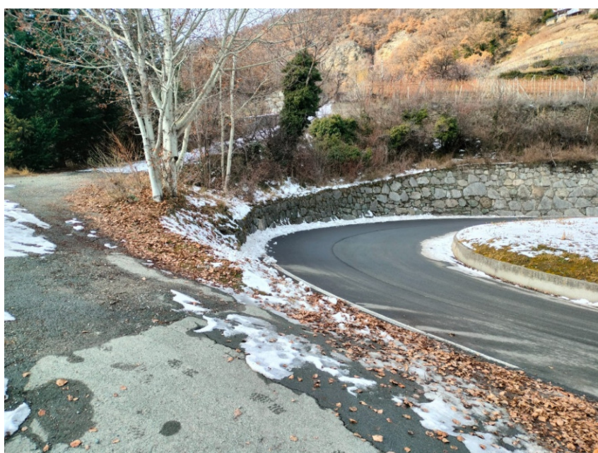
Figura 10 - Area di installazione della cabina - vista da valle
