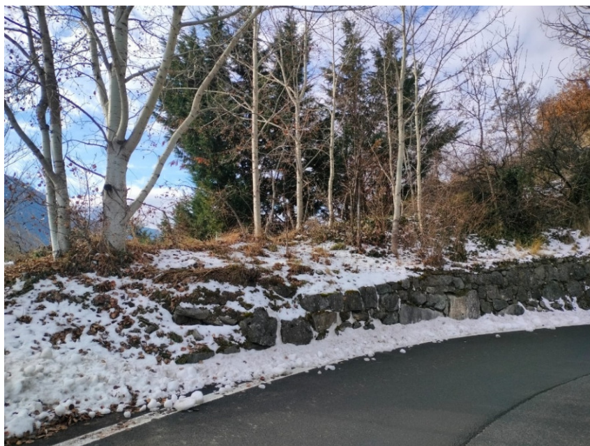
Figura 9 - Area di installazione della cabina – vista dalla strada
