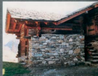
Gressoney-Saint-Jean recupero statico conservativo di n° 2 stadel a Grosso Albezo. Dall'alto: particolare della muratura sul lato nord dello stadel "A" prima e dopo l'intervento. A destra: particolare della ricostruzione della copertura conformemente alla tecnica di incastro originaria e locale interno dello stadel "A" dopo l'intervento di restauro.
