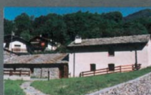
Challand-Saint-Anselme recupero del vecchio mulino di Ruvère Dal basso all'alto: prospetto sud prima dell'intervento, durante l'intervento e dopo l'intervento
