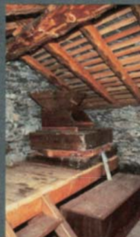
Gressoney-Saint-Jean recupero statico conservativo di n° 2 stadel a Grosso Albezo. Dall'alto: particolare della muratura sul lato nord dello stadel "A" prima e dopo l'intervento. A destra: particolare della ricostruzione della copertura conformemente alla tecnica di incastro originaria e locale interno dello stadel "A" dopo l'intervento di restauro.
