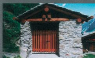
Valsavarenche: forno di Maisonasse, particolare dell'appoggio del colmo su orditura lignea recuperata.
