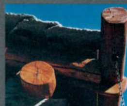
Valsavarenche: forno di Maisonasse, particolare dell'appoggio del colmo su orditura lignea recuperata.
