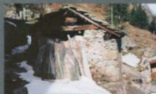
Valsavarenche: il prospetto sud del forno di Maisonasse prima, durante e dopo i lavori
