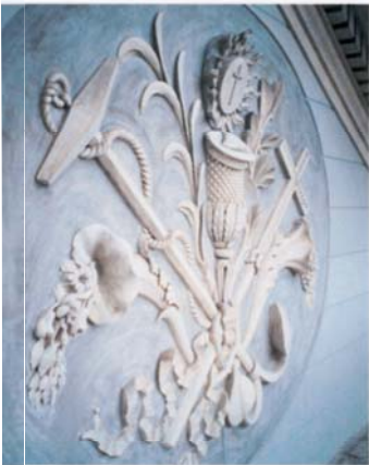
Aosta, facciata della cattedrale. Particolare dell'ornato del timpano prima e dopo l'intervento (Foto Diana Costantini)
