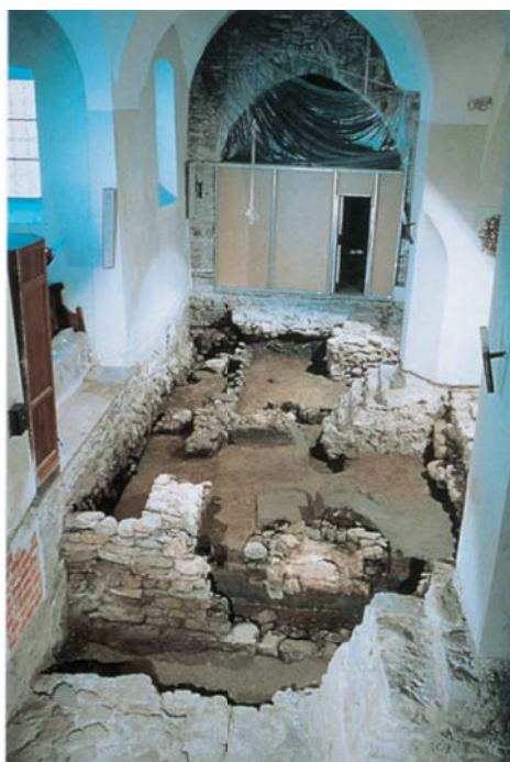
Morgex, chiesa di Santa Maria Assunta, veduta generale della navata nord in fase di scavo
