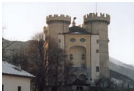
Castello di Aymavilles. Facciata est dopo il restauro. Facciata sud dopo il restauro. (Archivi della Soprintendenza per i beni e le attività culturali, foto D. Cesare)
