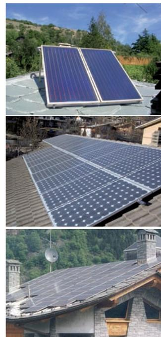
tensione e la potenza elettrica richiesta dall'impianto. L'energia elettrica prodotta è normalmente in corrente continua a bassa tensione. Per essere utilizzata dalle usuali apparecchiature elettriche deve essere trasformata in corrente alternata a 220 Volt: questo avviene attraverso l'uso di uno strumento chiamato 'inverter'.
