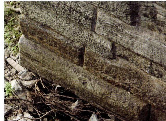
Détail de la cavité creusée pour soulever les blocs
