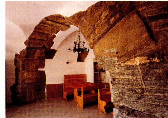
Arche du viaduc
