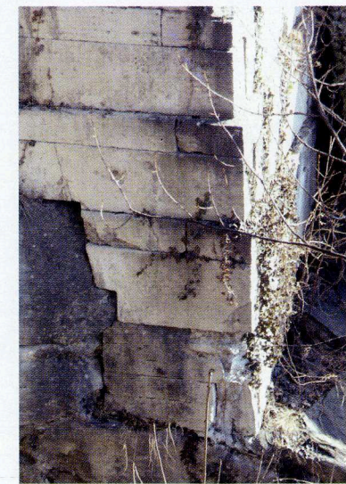
Détail du travail des blocs du pont
