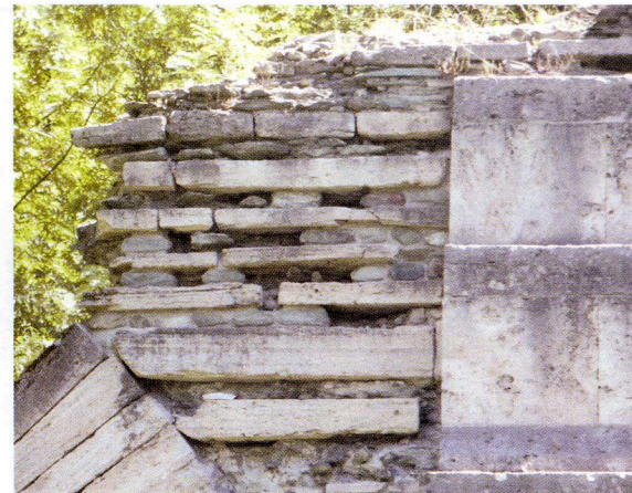
Détail du parement de la façade du pont
