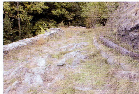
Vue des restes de la chaussée d'accès au pont
