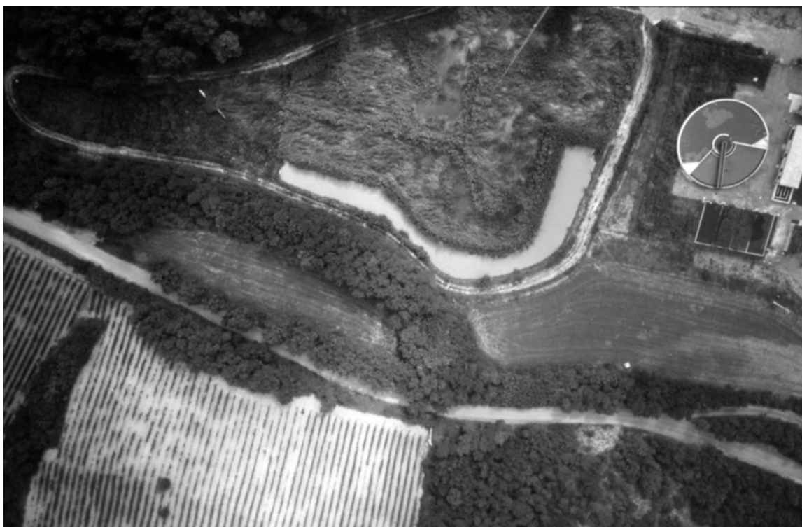
Fig. 21 - Visione aerea del depuratore e dell'ecosistema – filtro di Bobbio
