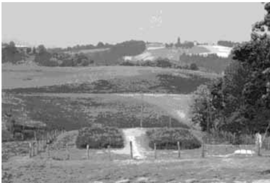
Fig. 20 - Le due vasche di fitodepurazione in parallelo
