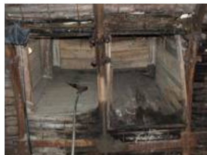
Rampe pour décharger le charbon
