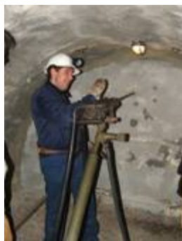
Avancement de la galerie par perforation
