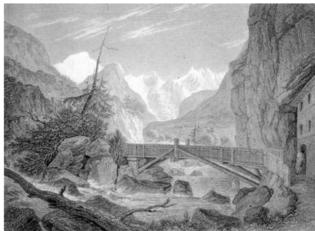
6. Il ponte in legno di Pré-Saint-Didier. (da Brockedon 1828)
