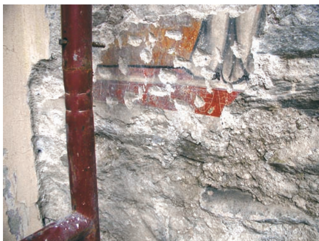
12. Frammento di affresco sul lato ovest del campanile. (F. Accordi)
