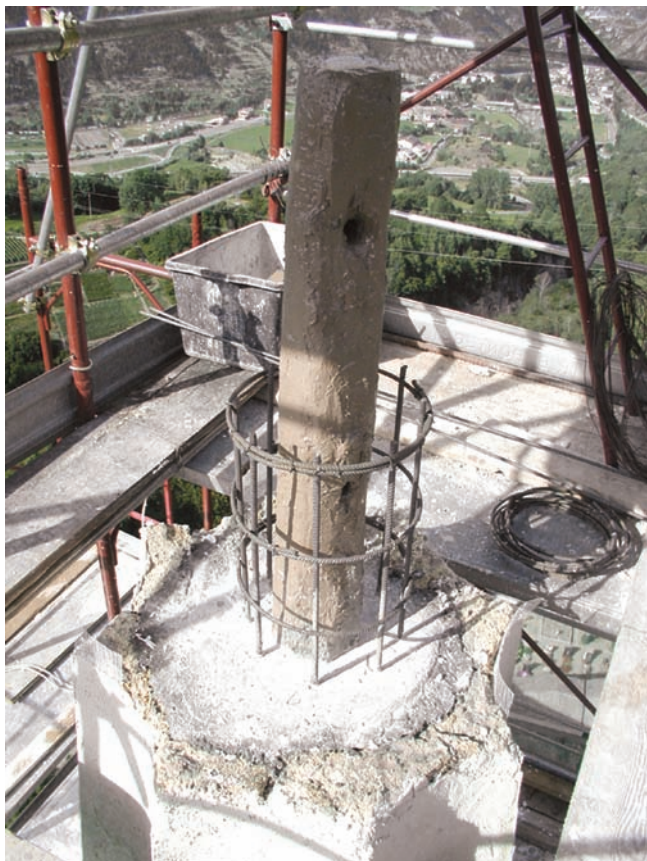
8. Particolare del consolidamento della sommità della cuspide. (F. Accordi)
