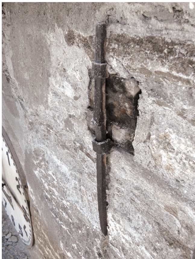
15. Una delle travi lignee di catena del 1430 con chiave in ferro inserita successivamente. (M. Cortelazzo)
