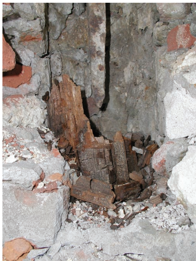
7. Particolare della sommità del palo centrale dell'incastellatura lignea della cuspide del campanile. (F. Accordi)
