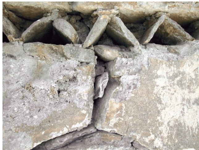
14. Particolare della fascia a triangoli sopra il coronamento della trifora del lato ovest. (M. Cortelazzo)
