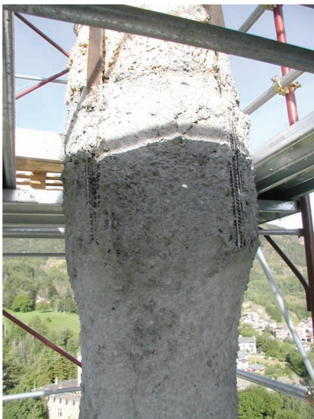
30. Il getto di calcestruzzo, da rivestire con la muratura. (F. Accordi)
