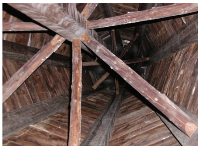
10. Incastellatura lignea interna alla cuspide del campanile. (F. Accordi)
