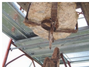
22. I codoli dell'asta portacroce e delle bandelle d'imbragatura, col cerchio che serra il palo-anima. (G. Vallacqua)
