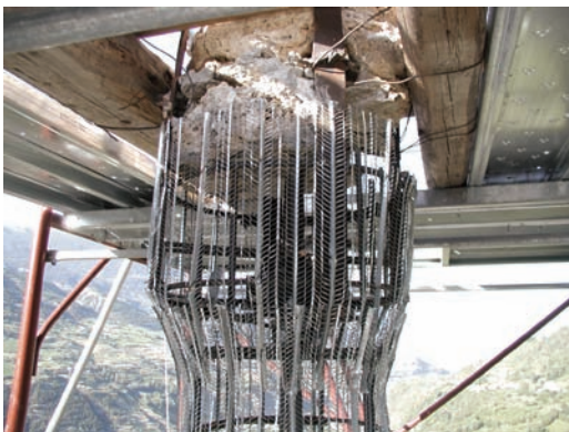
28. La casseratura in rete da intonaci della testata di ancoraggio. (F. Accordi)
