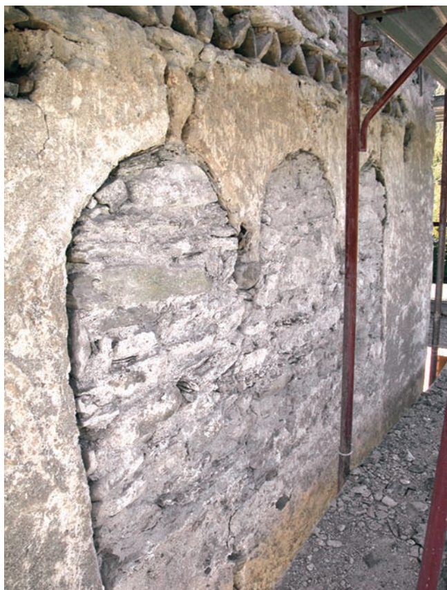
13. Trifora del terzo ordine tamponata sul fronte ovest. (M. Cortelazzo)
