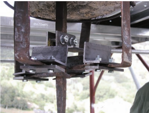
27. Le piastre di ritegno dei codoli di ferro. (F. Accordi)
