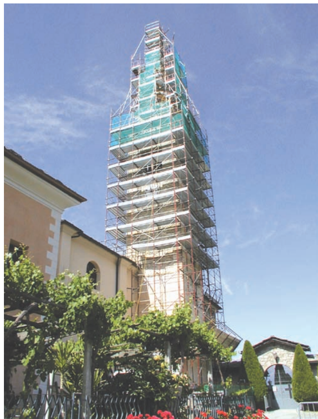
4. I ponteggi. (F. Accordi)
