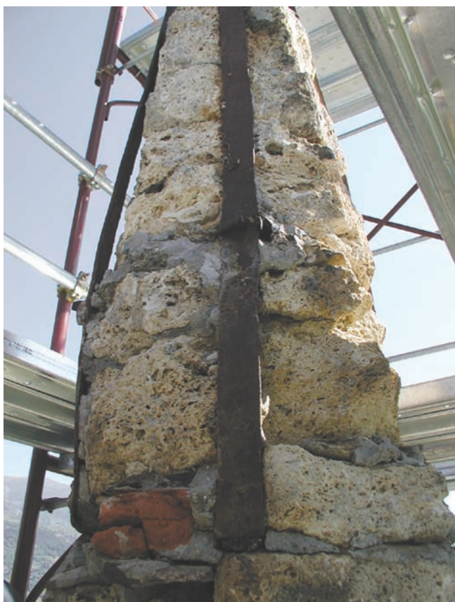
6. Particolare della sommità della cuspide prima dell'intervento di consolidamento. (F. Accordi)
