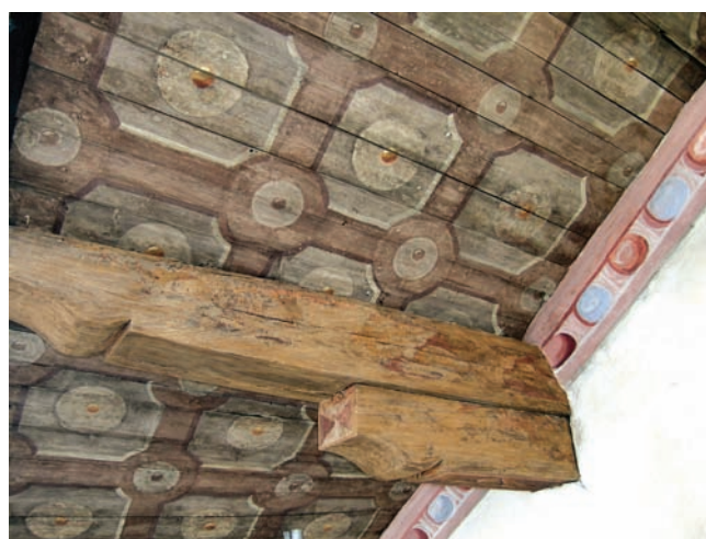
2. Particolare dell'intradosso della falda del tetto durante il restauro. (M. Bagagiolo)
