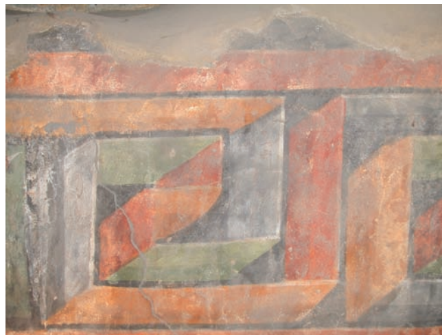
4. Partie de la décoration, on aperçoit les fissures et du dépôt de poussière sur l'irrégularité de la surface, en haut on retrouve la couche en mortier utilisée pour la couverture du sommet des murs. (L. Degani)
