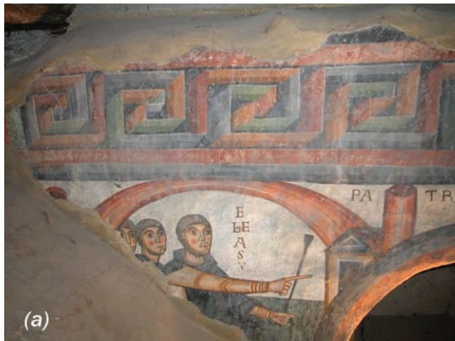
4. Partie de la décoration, on aperçoit les fissures et du dépôt de poussière sur l'irrégularité de la surface, en haut on retrouve la couche en mortier utilisée pour la couverture du sommet des murs. (L. Degani)
