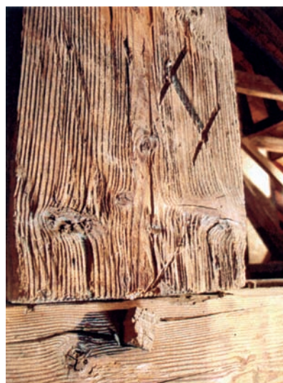
3. Marchio su trave verticale o montante 77, che rappresenta un incastro tenone/mortasa, fermato da una caviglia, con il trave 73. (M. Cortelazzo)
