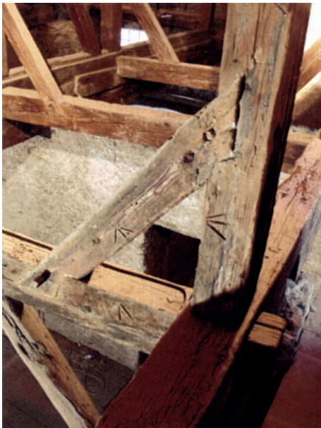
5. Serie di marchi su catena 141, controventatura 139 e montante 138. La controventatura presenta incastri a 1/2 coda di rondine fermati da caviglie. (M. Cortelazzo)
