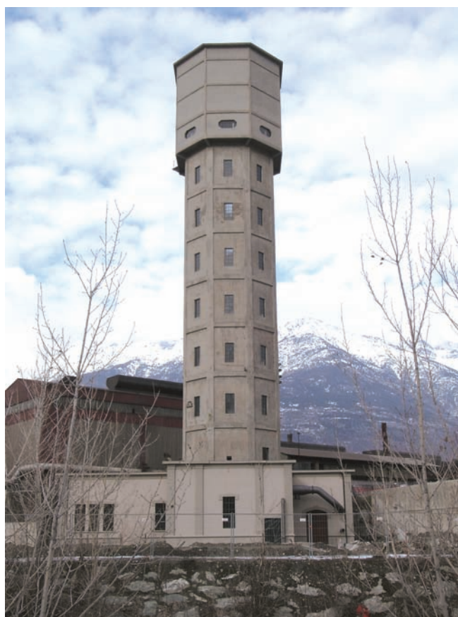
1. Veduta della torre piezometrica dopo l'intervento di restauro. (P. Fioravanti)
