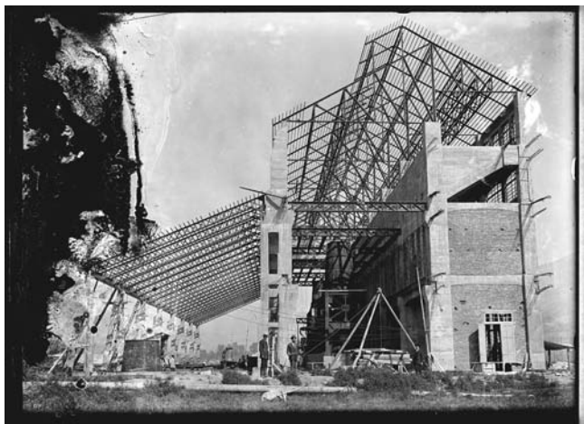
5. Esempio di degrado: distacco dell'emulsione. (Lastra n. inv. 1521 archivio ex-Cogne)
