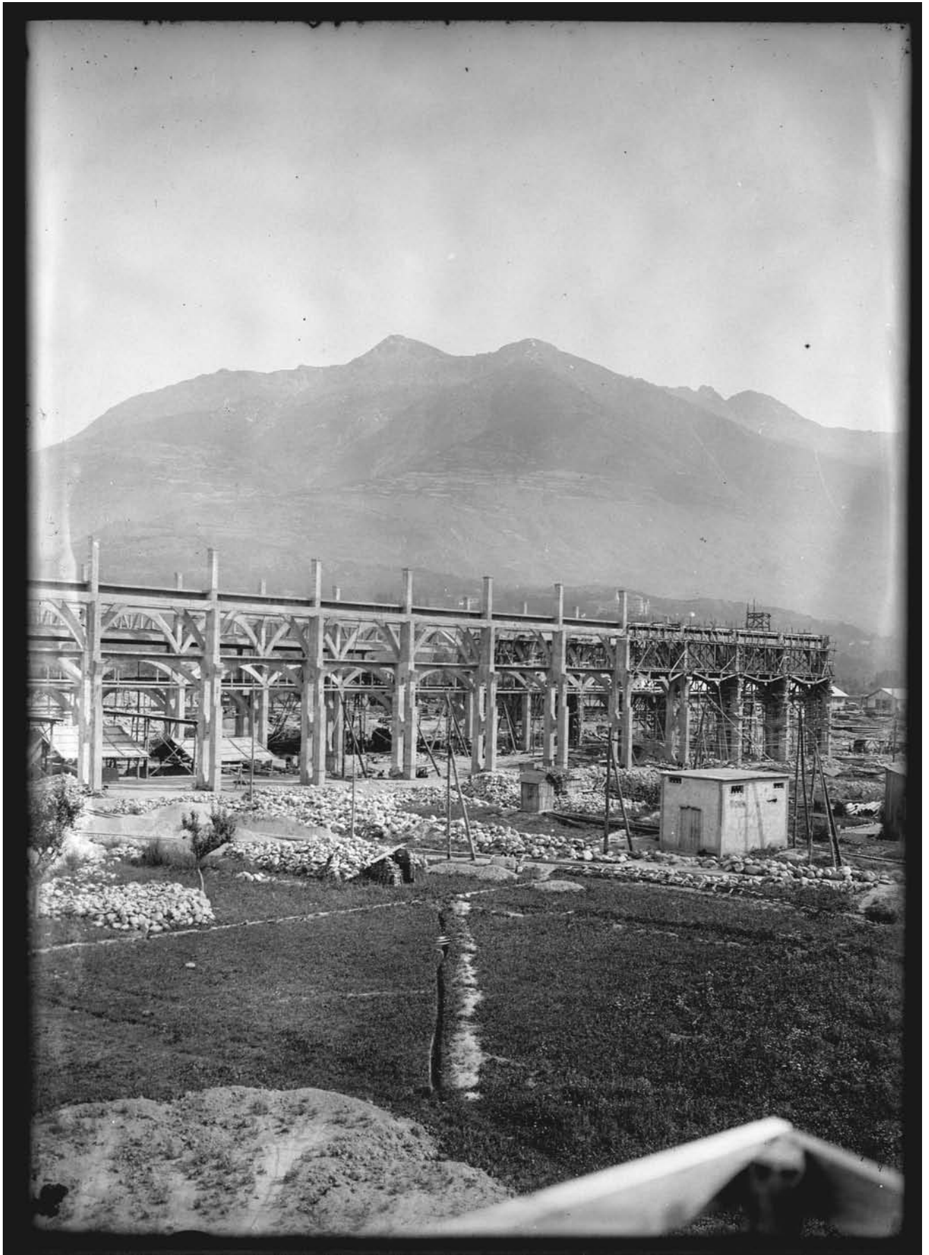
2. Veduta dello stabilimento in costruzione. (Lastra n. inv. 1560 archivio ex-Cogne)
