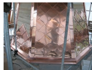
7. - 8. - 9. - 10. Cuspidè del campanile rivestita in scandole di rame; particolari delle fasi esecutive. (don P. Papone)
