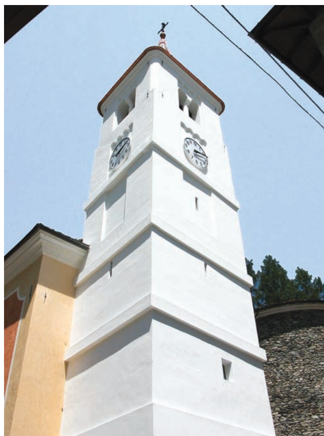
12. Veduta del campanile da sud, a fine lavori. (don P. Papone)
