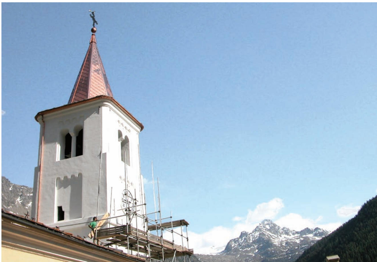
11. Veduta da ovest, durante i lavori. (don P. Papone)
