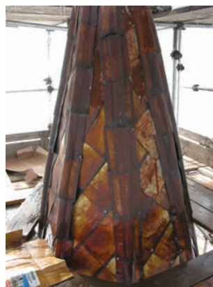
7. - 8. - 9. - 10. Cuspidè del campanile rivestita in scandole di rame; particolari delle fasi esecutive. (don P. Papone)
