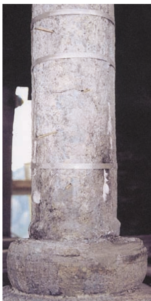
4. - 5. - 6. Particolari delle operazioni di consolidamento. (M. Monegato)
