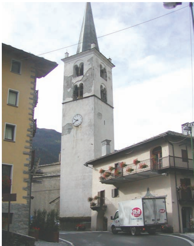
1. La torre campanaria nel 2003, prima dei lavori di restauro. (I. Perrin)
