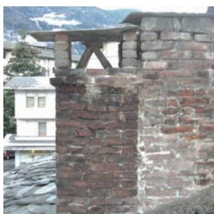
47. En toiture, deux phases nettes de construction des souches de cheminées. (C. Remacle)
