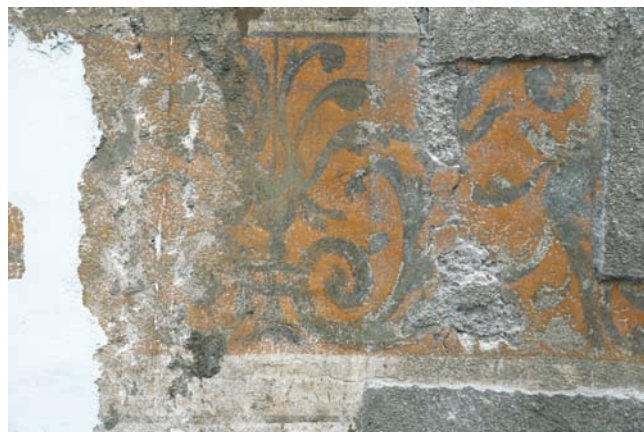
35. Facciata meridionale. Particolare della cornice a racemi. (G. Di Carlo)
