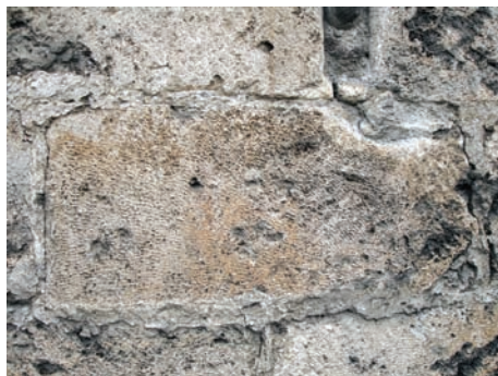
10. - 11. - 12. Particolare della lavorazione a gradina dei blocchi di travertino. (M. Cortelazzo)
