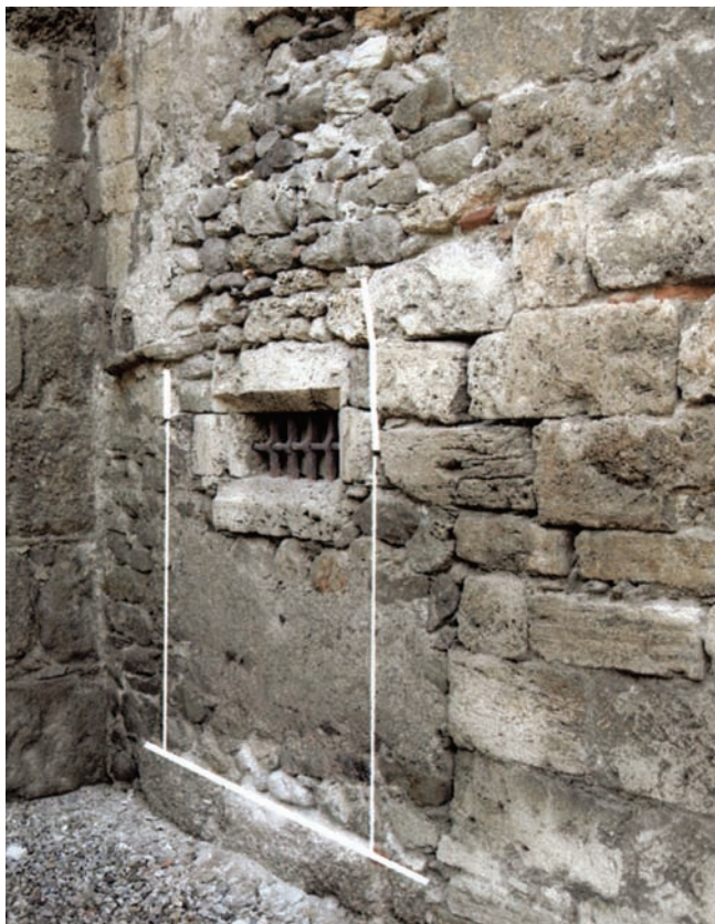
30. Tracce dell'esistenza di un portale sulla fronte nord accanto alla parete della torre. (M. Cortelazzo)
