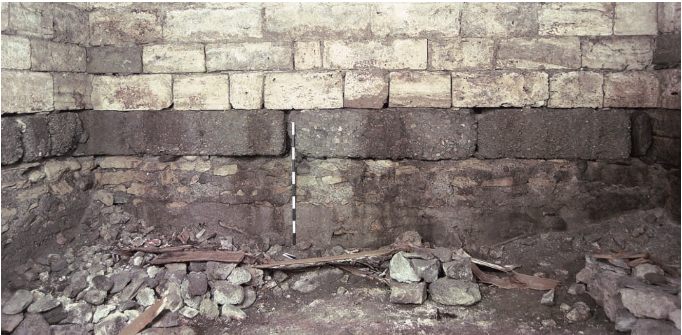
17. Il vano inferiore della torre al momento del primo ingresso con le tavole lignee ancora in situ. (M. Cortelazzo)
