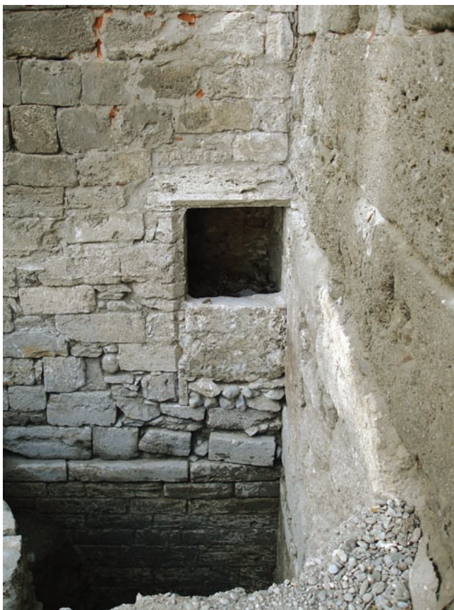
18. Il passaggio nell'angolo a nord-est che dava accesso al sottoscala ed al passaggio in rottura per l'ingresso all'interno della torre. (M. Cortelazzo)
