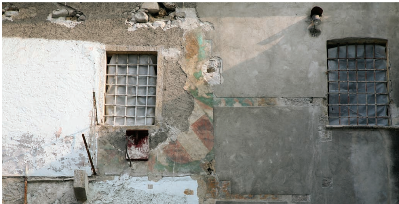
33. Facciata meridionale. Veduta generale. (G. Di Carlo)
