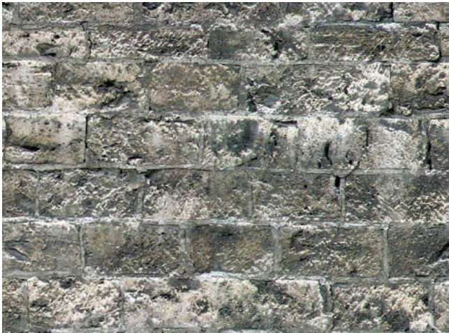
14. Particolare della stilatura "a nastrino sporgente" dei giunti sui corsi del lato nord della torre. (M. Cortelazzo)
