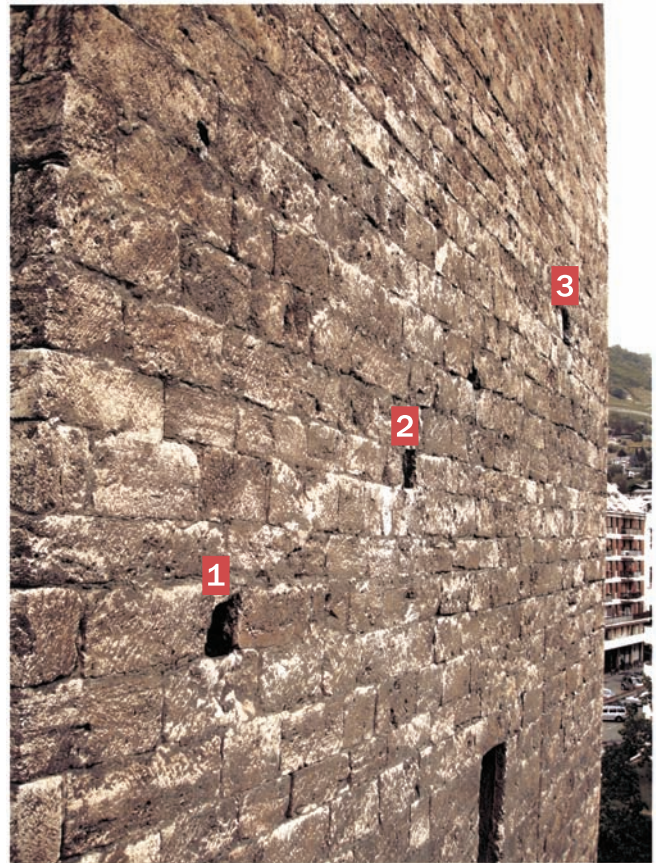
25. L'allineamento delle buche pontaias sul lato est. (M. Cortelazzo)
