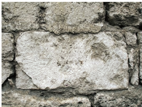
10. - 11. - 12. Particolare della lavorazione a gradina dei blocchi di travertino. (M. Cortelazzo)
